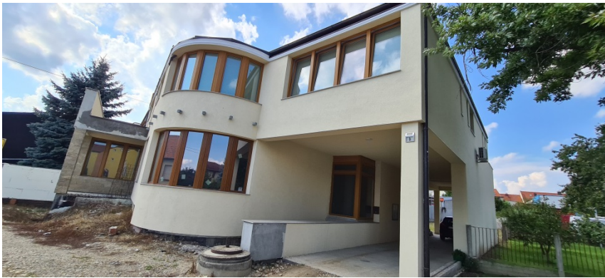
Slika 71; Kuća u izgradnji, slikano 26. kolovoz 2020., 15:48:23 (slika autora)
