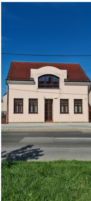
Slika 87; Jednokatnica pod k.b. 23, slikano 27. kolovoz 2020., 15:09:56 (slika autora)
