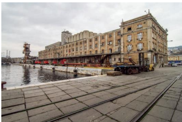
Slika 19: Lučka skladišta 12 i 13 (Nadilo i Regan, 2015.)
