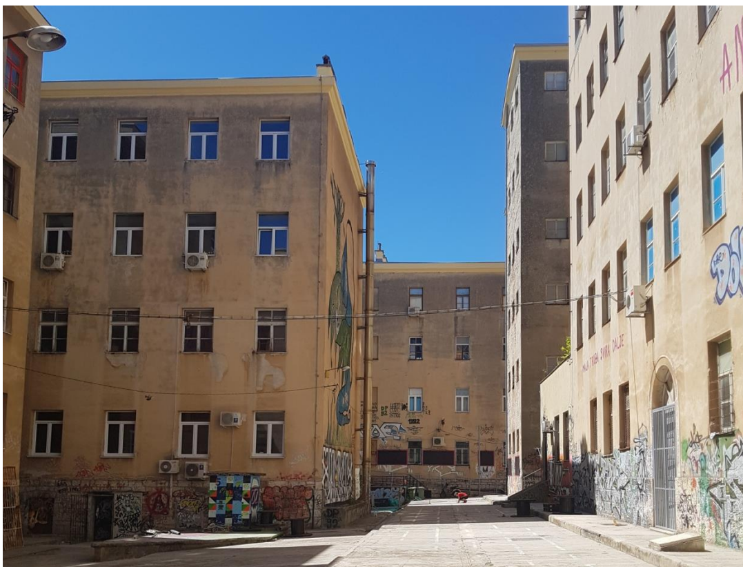
Slika 64. Unutarnje dvorište - pogled na istočnu stranu zapadnog dijela (Foto: autor)
