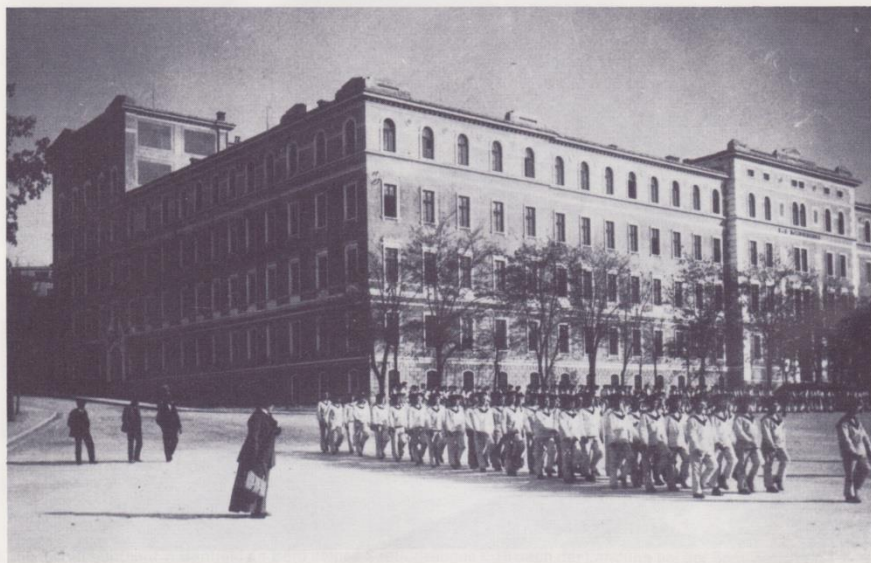
Der Gebäudekomplex der Maschinenschule Pola, Aussehen nach den letzten Umbauten bis zu Kriegsende.
