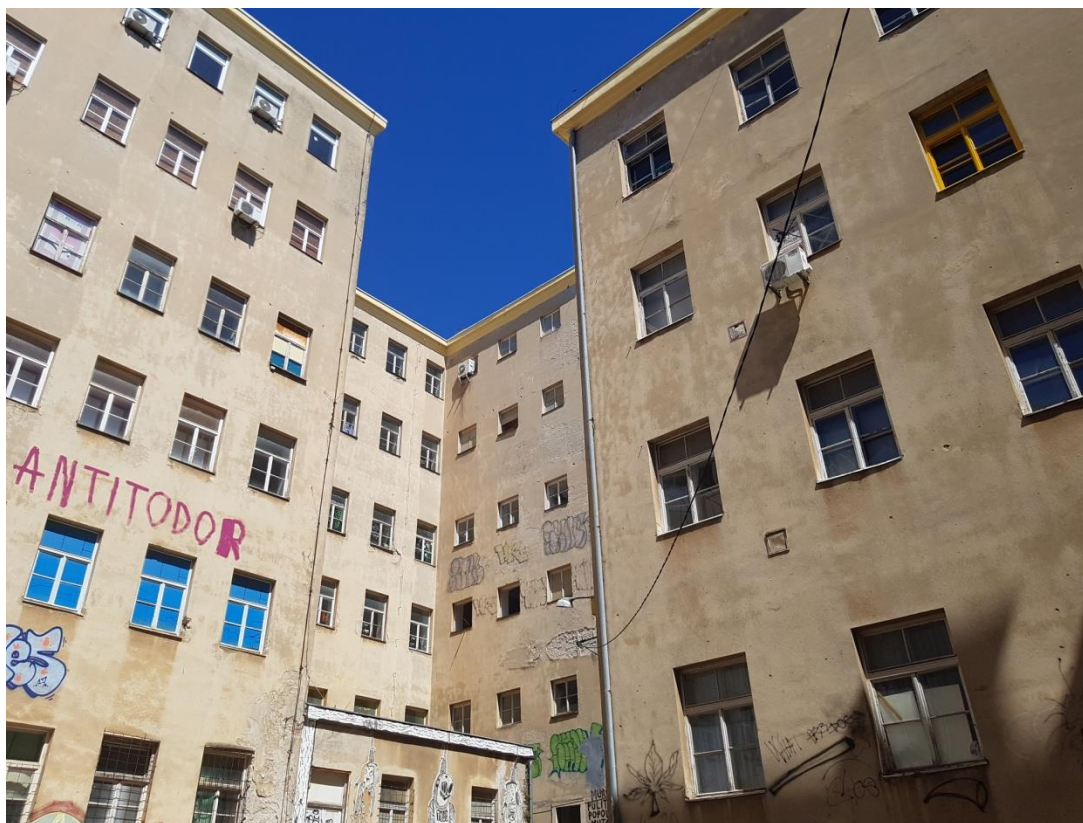
Slika 62. Unutarnje dvorište - pogled na zapadnu stranu istočnog dijela (Foto: autor)
