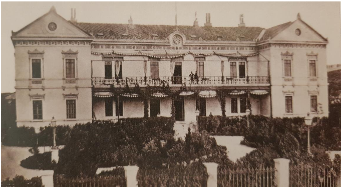
Slika 16. Stara zgrada Mornaričkog kasina (Dobrić i drugi, 2014.)
