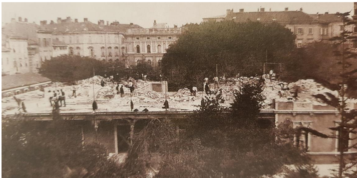
Slika 17. Rušenje stare zgrade Mornaričkog Kazina (Dobrić i drugi, 2014.)
