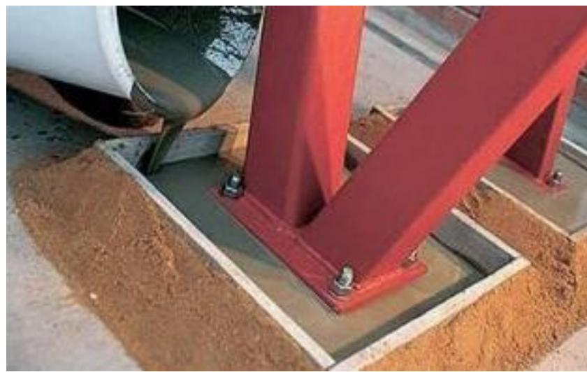
Slika 46. Podlijevanje morta ispod bazne ploče [31]
