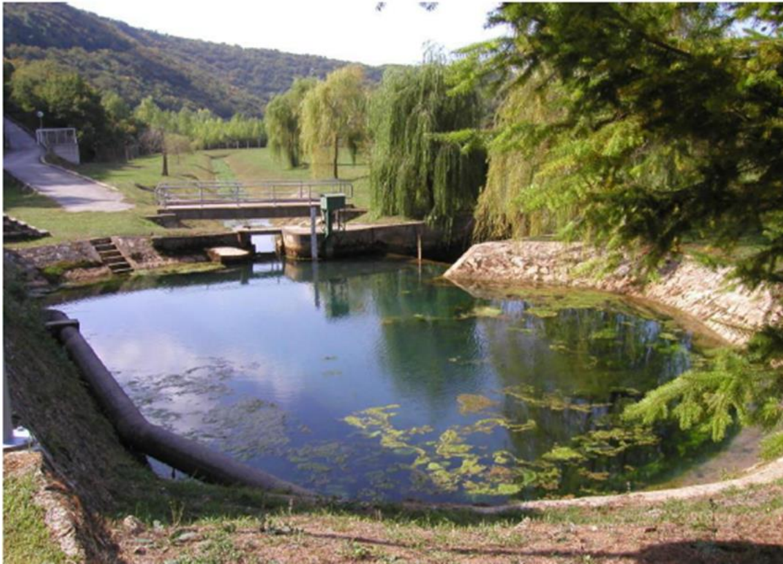
Slika 2. Izvor Gradole – pogled na jezersko oko ispred crpne postaje [3].
