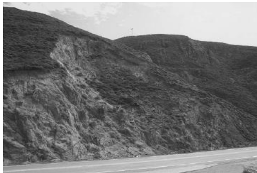
Slika 22. Kružni slom ravnine u visoko istrošenim granitnim stijenama (Wyllie and Mah, 2005)
