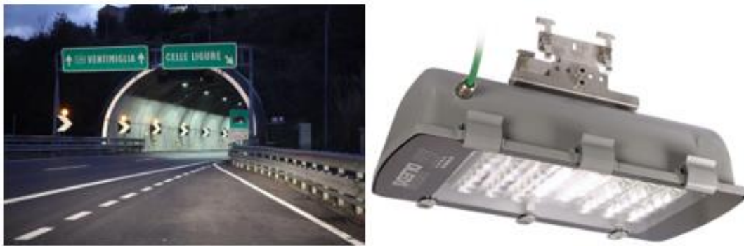
Slika 34: Led rasvjeta tunela [30]
