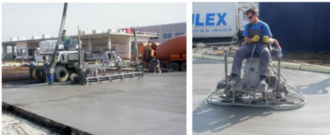
Slika 7: Ugradnja hibridne mikroarmirane betonske mješavine (lijevo) i završna obrada (desno) [7]
