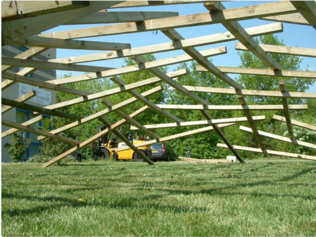
Slika 3: Jedna od punih dimenzija da Vincijeve kupole Rinusa Roelofsa.
