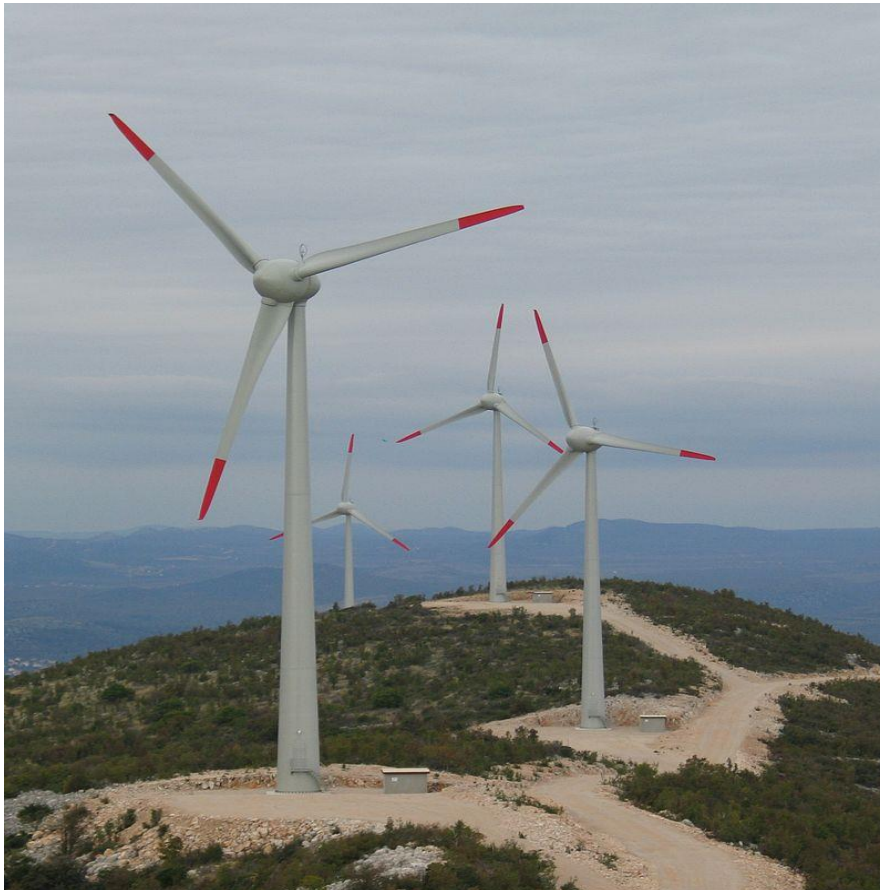
Slika 38. Visinska vjetroelektrana Trtar-Krtolin
