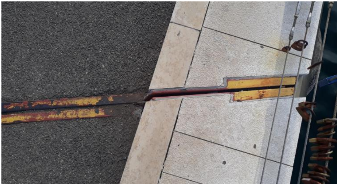
Slika 32: Prijelazna naprava na mostu
