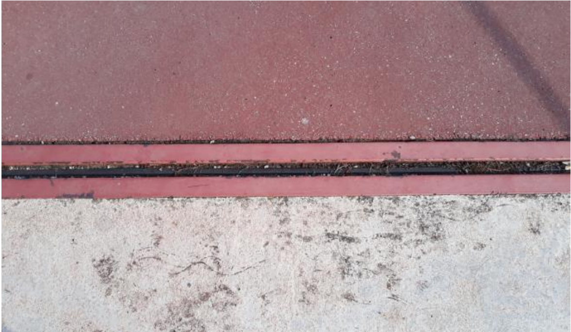
Slika 40: Prijelazna naprava na mostu
