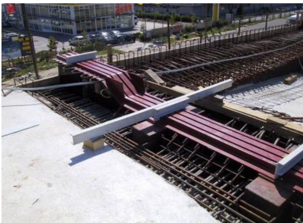
Slika 13: Naprava s elastomernim brtvenim ulošcima[9]
