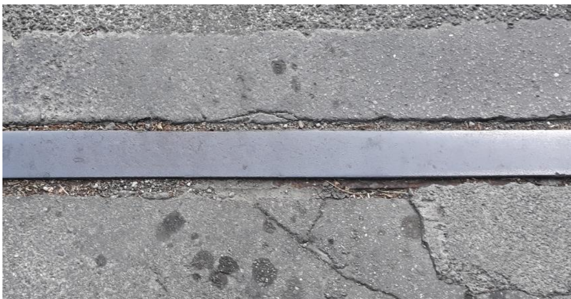
Slika 24: Prijelazna naprava na mostu Trnovica
