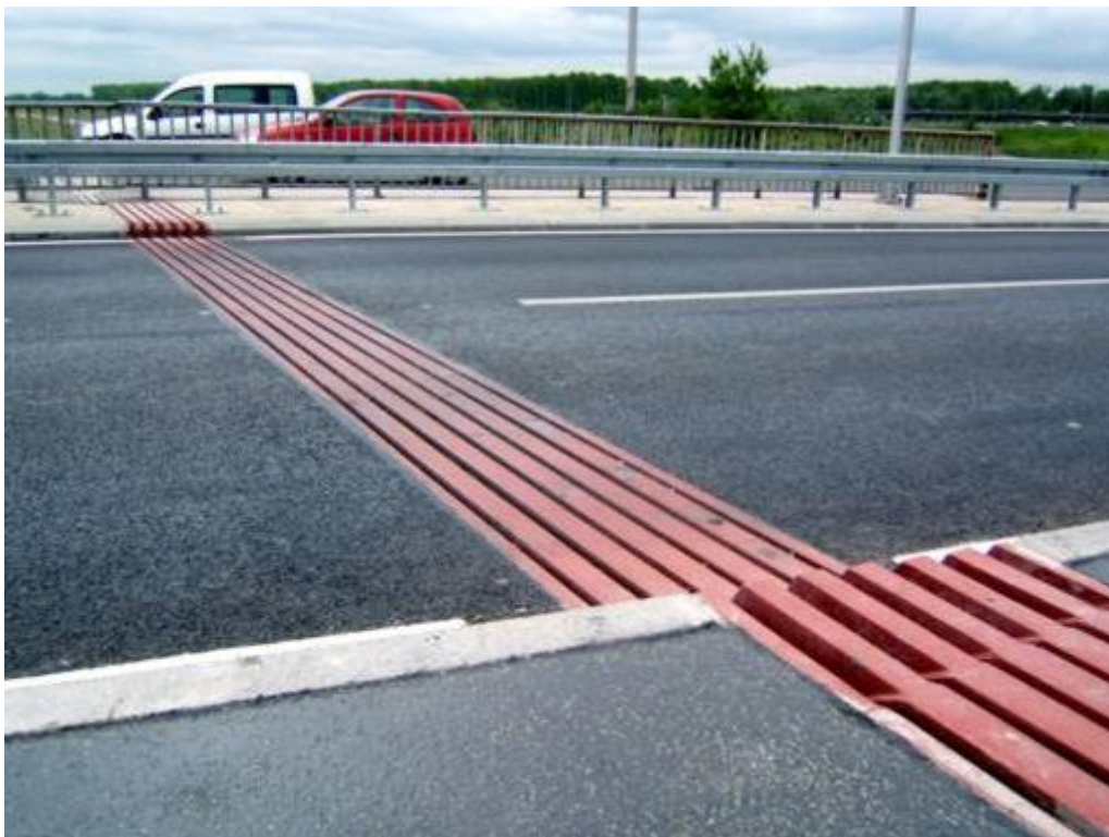
Slika 11: Naprava s elastomernim brtvenim uloščima[9]
