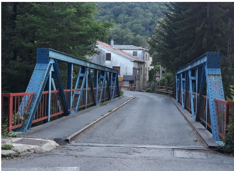
Slika 23: Pogled na most Trnovica s prednje strane
