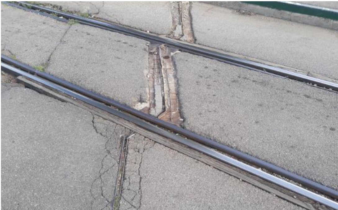
Slika 45: Prijelazna naprava na mostu
