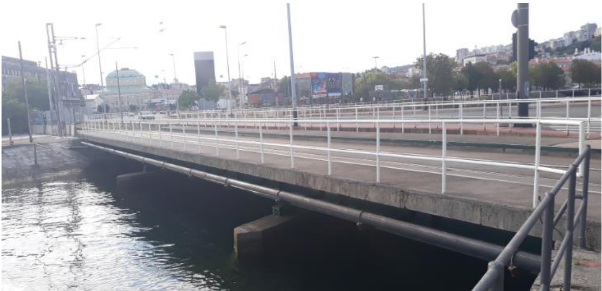
Slika 43: Pogled na most
