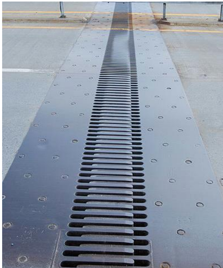
Slika 16: Češljasta (prstasta) prijelazna naprava [12]
