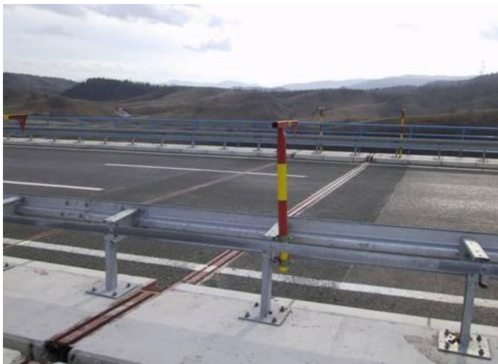
Slika 12: Naprava s elastomernim brtvenim ulošcima[9]
