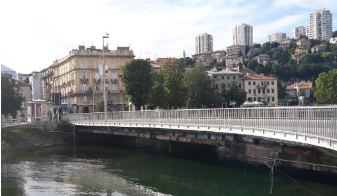
Slika 34: Pogled na most sa strane
