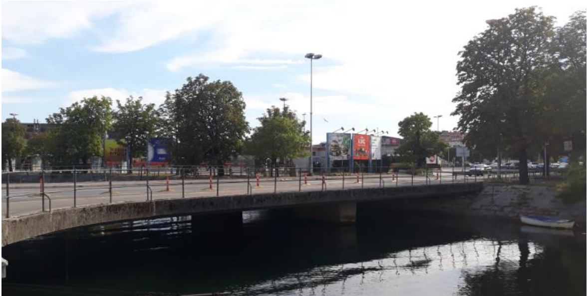
Slika 46: Pogled na most
