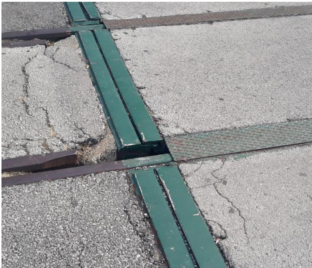
Slika 30: Prijelazna naprava na mostu
