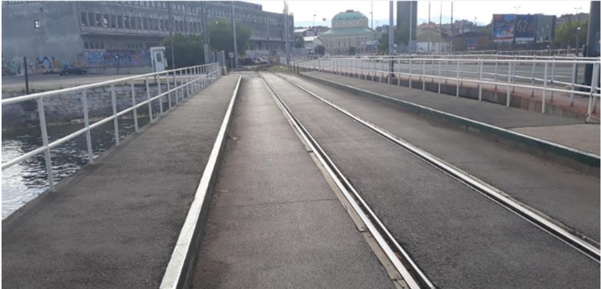
Slika 42: Pogled na most s prednje strane
