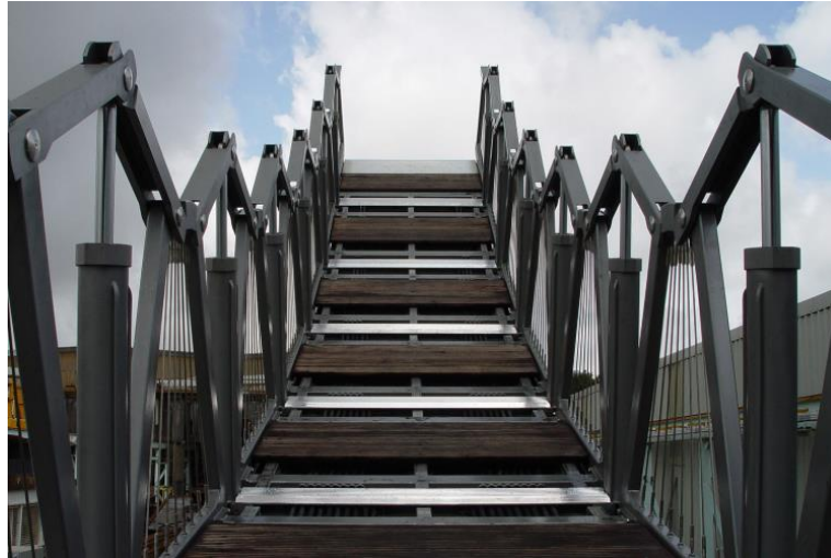
Slika 33: Pogled na nogostup mosta [22]
