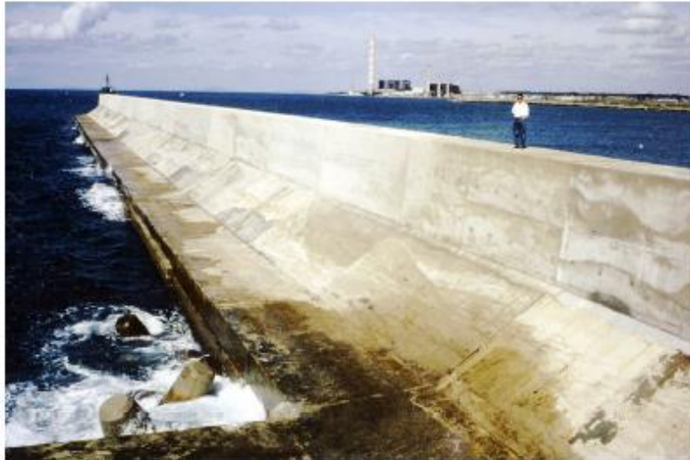
Slika 33. Parapetni zid na vrhu kesonskog lukobrana [28]
