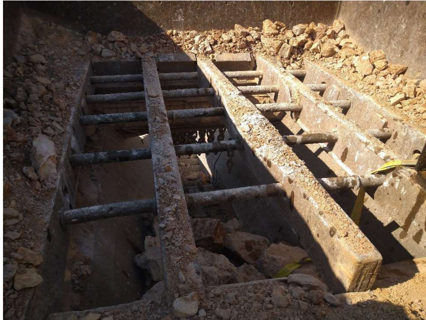
Slika 2: Zaštitna rešetka na ulazu u postrojenje. (fotografirao autor)
