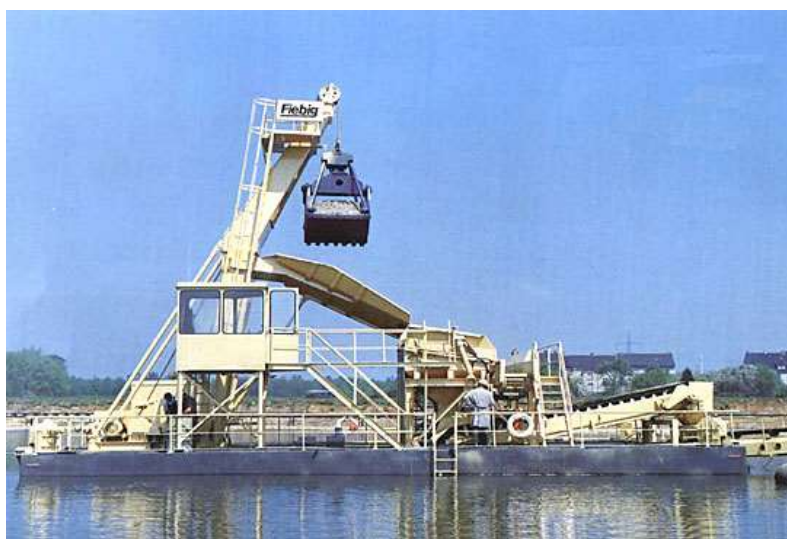
Slika 9: Plutajući bageri s hidrauličnom rampom i grajferom zapremine do 12m 3 [13]
