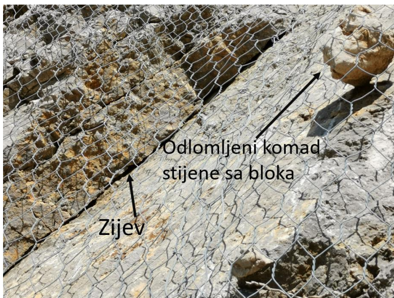
Slika 21. Prikaz detalja zijeva te hrapavosti površine diskontinuiteta 225/41. Ustanovljen je manji odronjeni blok. (Fotografija: Filip Marfan).
