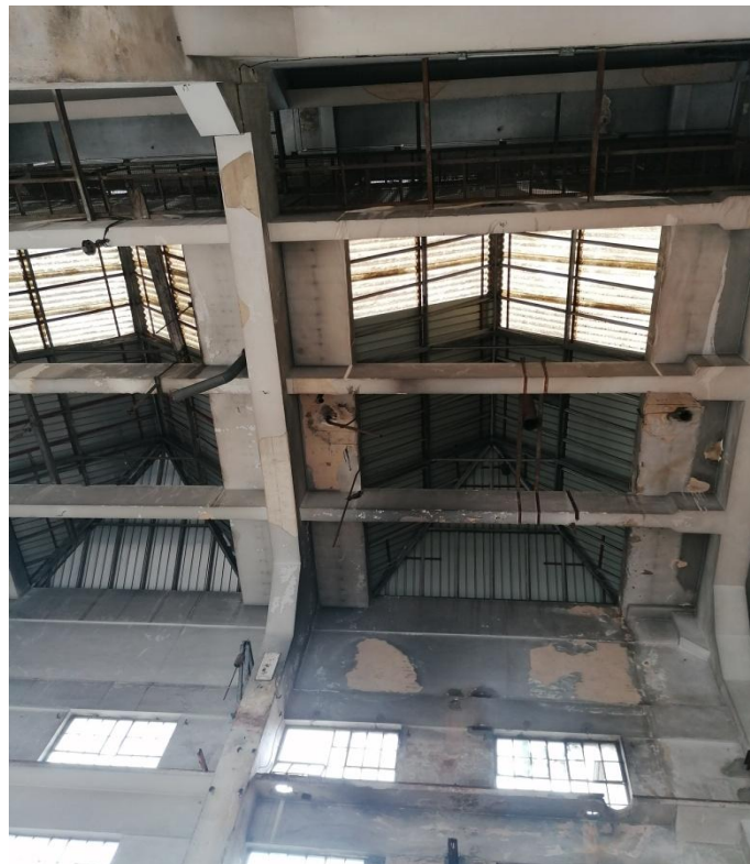
Slika 74. Rešetkasta armiranobetonska konstrukcija stropa iznad "dvorane kotlova"
