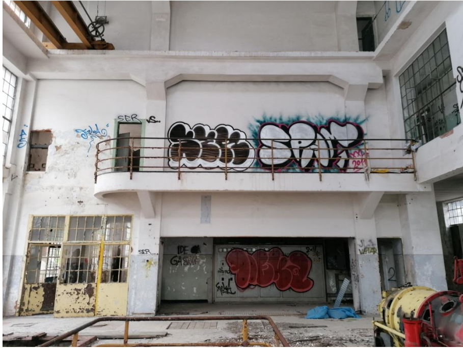
Slika 69. Pogled iz "dvorane turbina" prema galeriji koja se nalazi na drugom katu i prostoru kretanja dizalice na trećem katu
