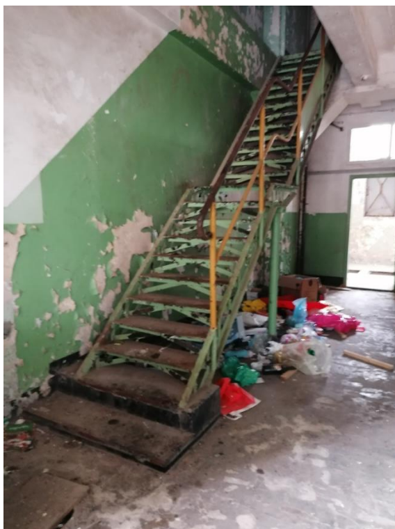
Slika 75. Stubište koje povezuje prvi i drugi kat zgrade
