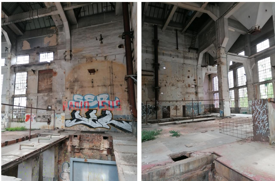
Slika 72. „Dvorana kotlova“ na prvom katu zgrade
