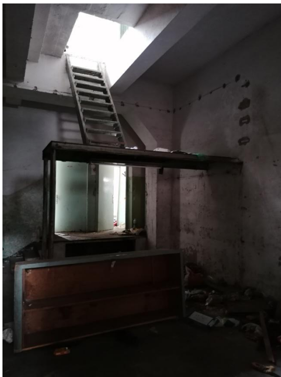
Slika 76. Dio drvenog stubišta koje povezuje drugi i treći kat
