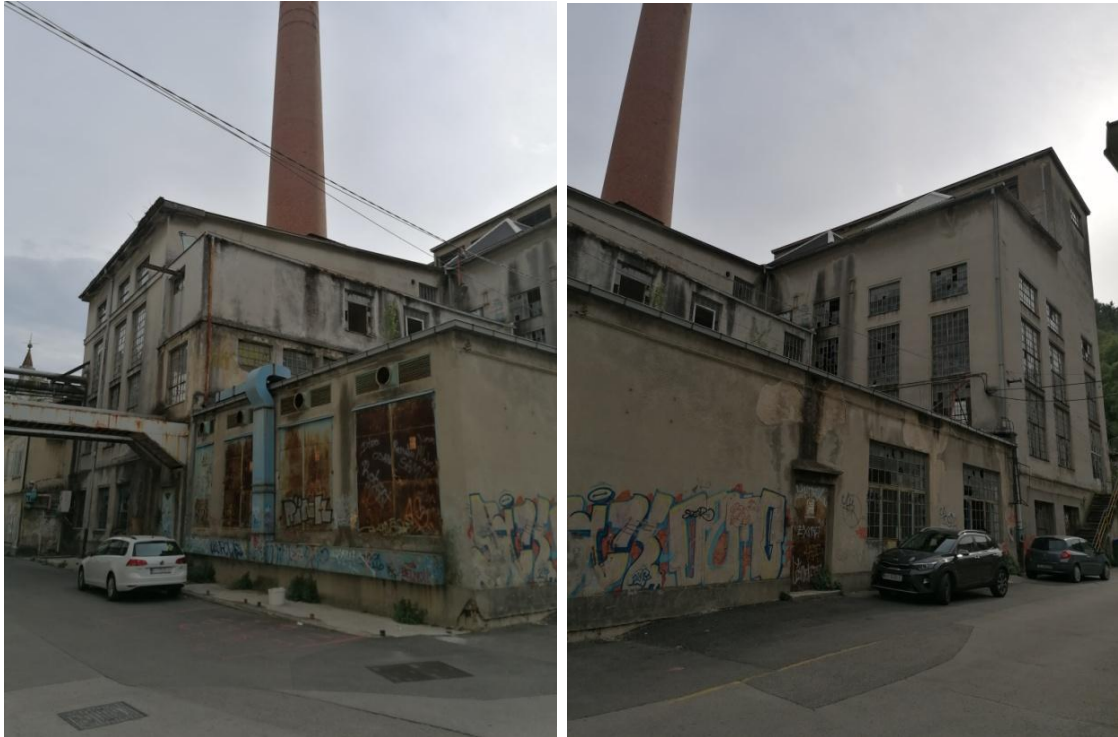
Slika 63. Pogled na istočno i sjeverno pročelje zgrade
