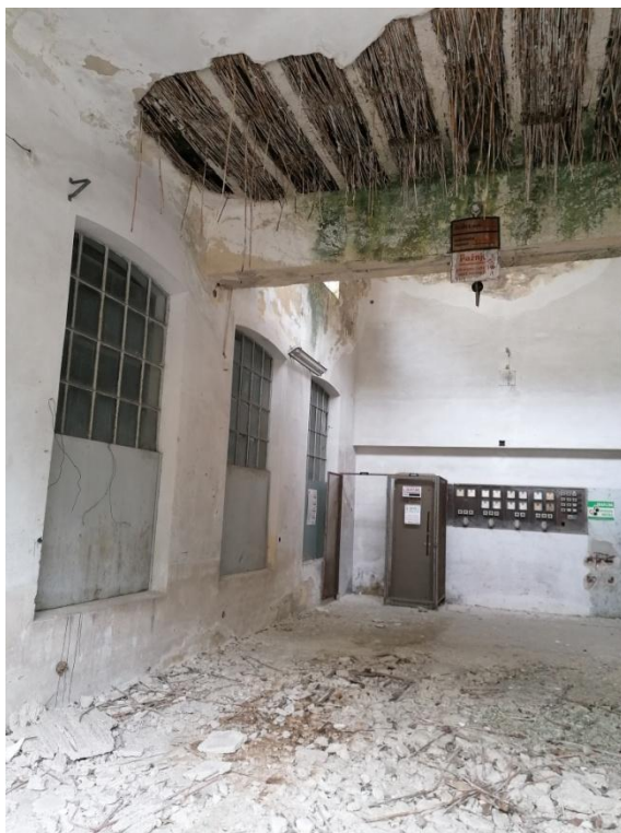
Slika 78. Prostor elektro radionice gdje je vidljivo da je međukatna konstrukcija izvedena sistemom „Hoyer“
