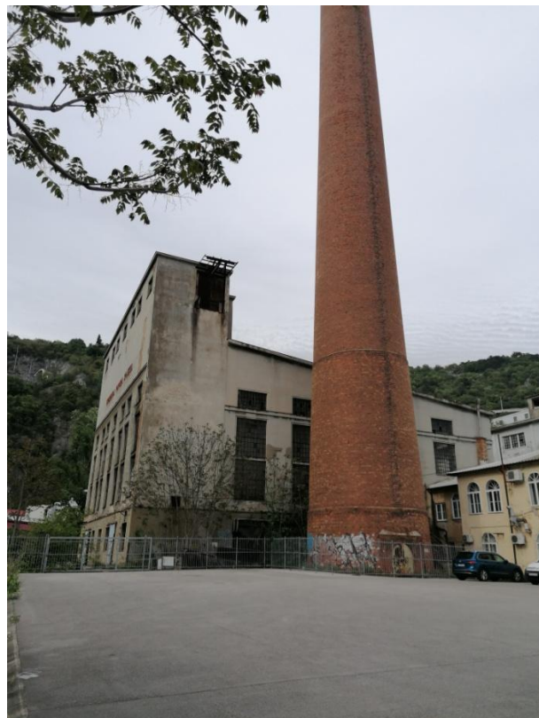
Slika 64. Južno pročelje zgrade
