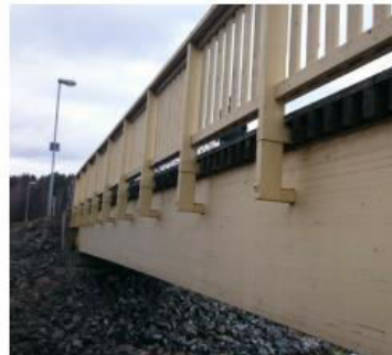
Slika 24: Primjer kvalitetnog detalja spoja i oslanjanja (lijeva slika), primjer premaza i spoja ograde (desna slika) [5]
