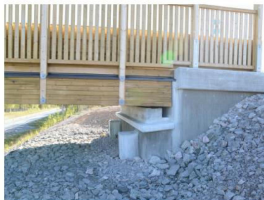
Slika 17: Ventilacija i odvojenost ležaja od tla (desna slika) – prozračnost i čistoća ležajnog dijela konstrukcije[5]
