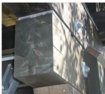
Slika 22: (lijeva slika) razvoj pukotina zbog nezaštićenog čeonog presjeka, (desna slika) zaštita kratkim čeličnim elementima kod izloženog dijela drva kod spoja[5]
