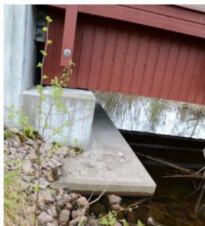
Slika 17: Ventilacija i odvojenost ležaja od tla (desna slika) – prozračnost i čistoća ležajnog dijela konstrukcije[5]
