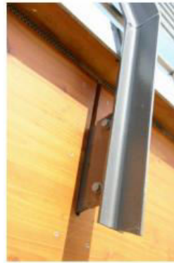
Slika 23: Produženi čelični dio radi odvajanja vode od konstrukcije (desna slika), čelični element uz drveni dio pospješuje smjer vode u drveni dio konstrukcije – loš detalj (lijeva slika) [5]
