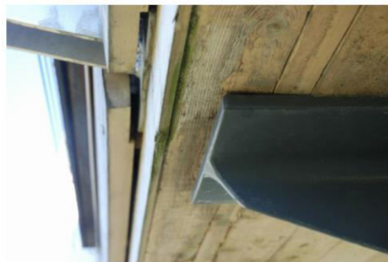
Slika 19: Uvučenost čeličnog nosača radi sprječavanja zadržavanje vode (desna slika) [5]
