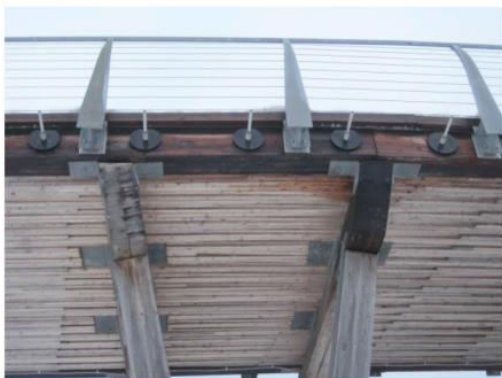
Slika 19: Uvučenost čeličnog nosača radi sprječavanja zadržavanje vode (desna slika) [5]
