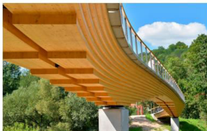
Slika 102: Prikaz zakrivljenog stepeničastog blok LLD nosača[14]
