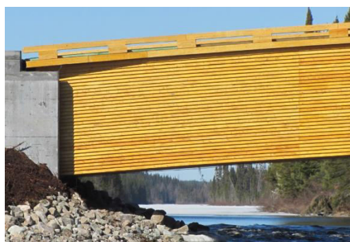
Slika 21: Zaštita glavnog nosača oblogama (desna slika) [5]
