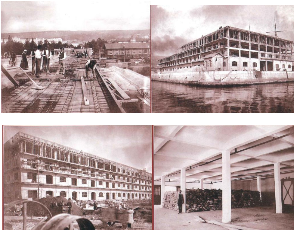
Slika 4: Fotografije izgradnje Skladišta 17 [ 8 ]
