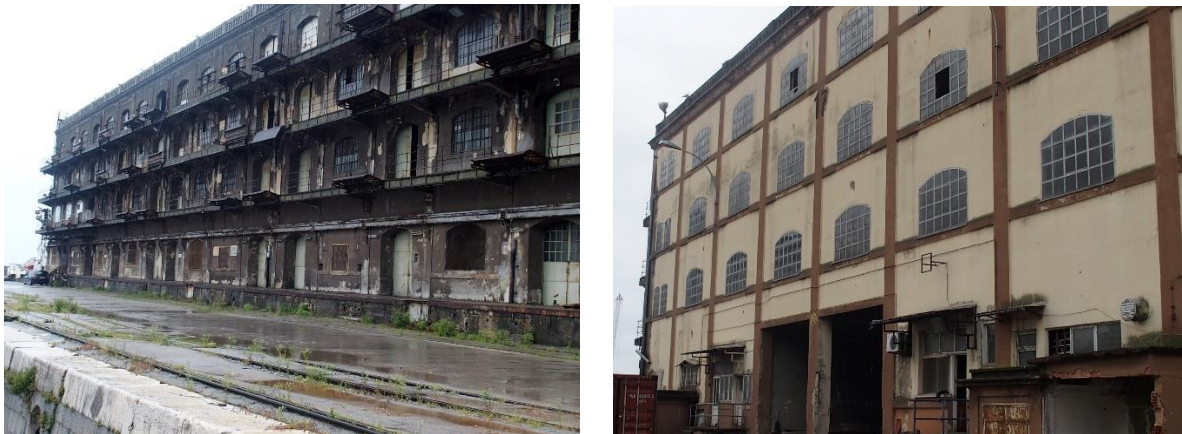
Slika 2: Izgled fasade na zgradi
