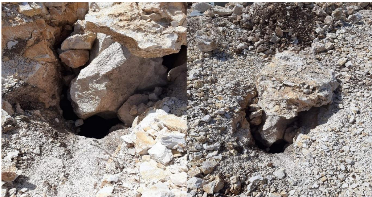
Slika 4. Fotografije kaverni koje su otkrivene prilikom izvedbi zemljanih radova; [privatna arhiva, Megi Ahmetović]
