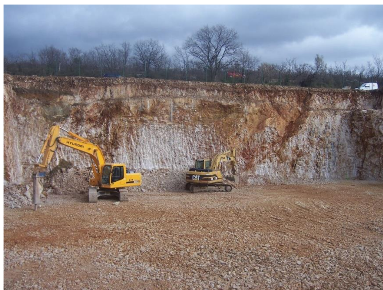
Slika 33: Građevna jama - pokos sjever [32]
