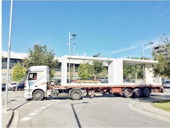
Slika 55: Transport armiranobetonskog prstena [1]
