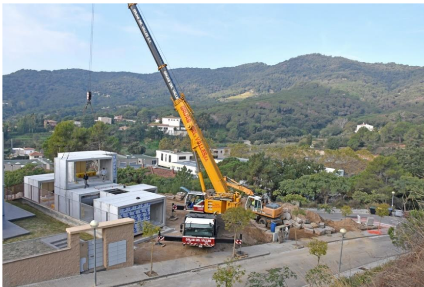
Slika 57: Postavljanje prstenastih ćelija na gradilištu [1]
