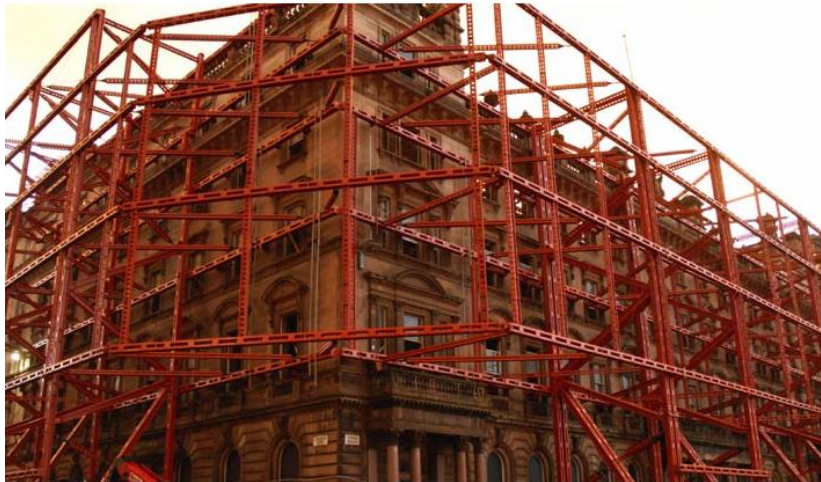
Slika 24: Privremena konstrukcija za pridržavanje fasade [9]
