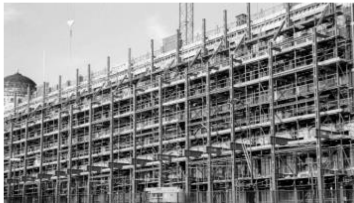
Slika 19: Vanjski konstrukcija za pridržavanje fasade [2]
