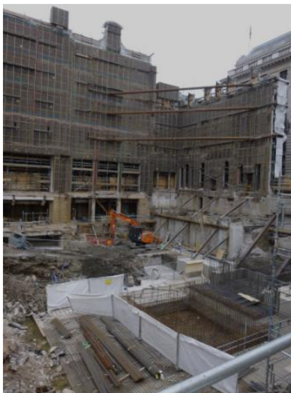
Slika 22: Podupiranje fasadnih zidova prilikom izvedbe podruma na dubini od 10 m [8]
