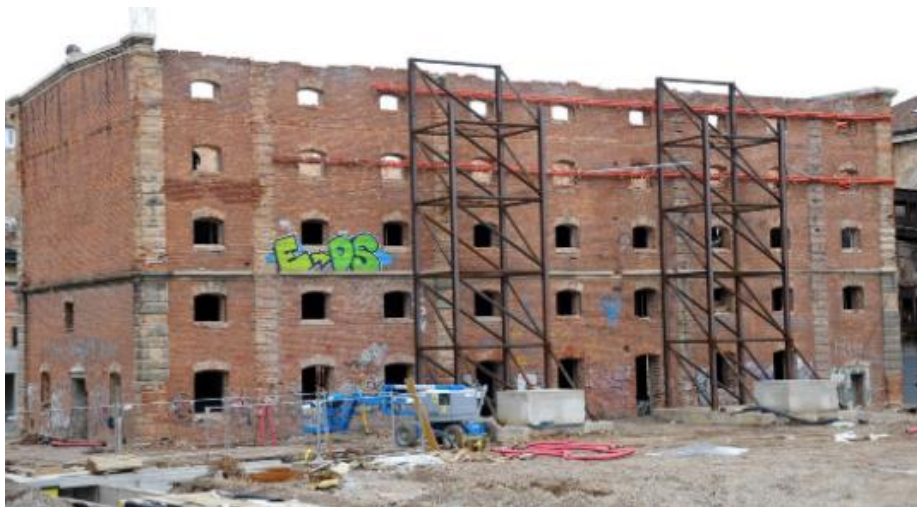
Slika 36: Teška skela za zadržavanje fasade [16]
