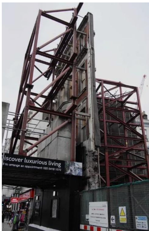
Slika 6: Kombinirana privremena konstrukcija [6]
