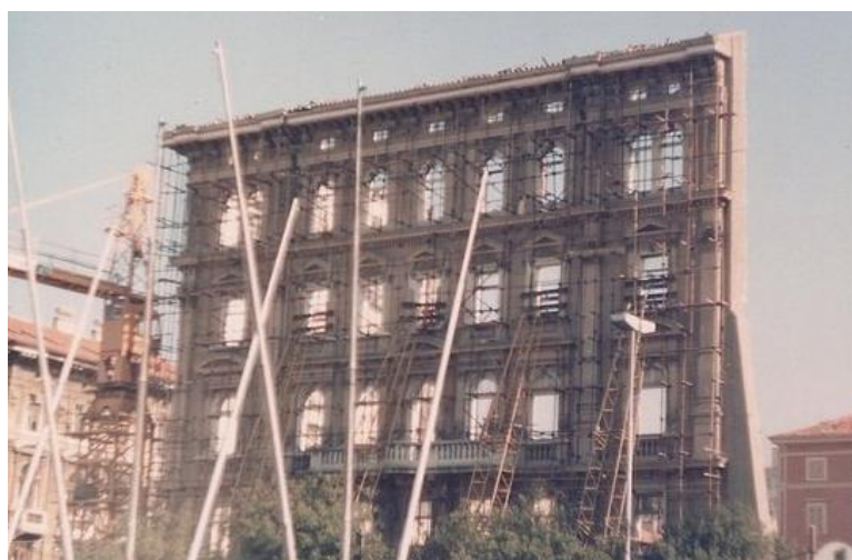
Slika 26: Pridržavanje fasadnog zida palače Mučović-Rinaldi [10]
