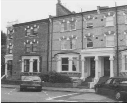
Slika 16: Kuća u Londonu-kontrast između dijela fasade koja je očišćen i dijela koji nije [2]
