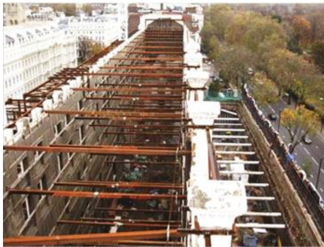
Slika 12: Razupiranje profilima [1]
