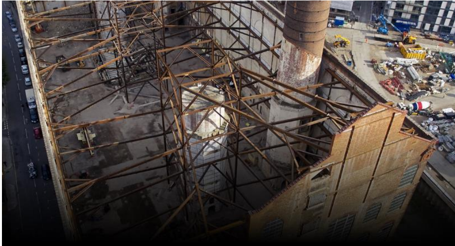
Slika 5: Unutarnja privremena konstrukcija za pridržavanje fasade [6]
