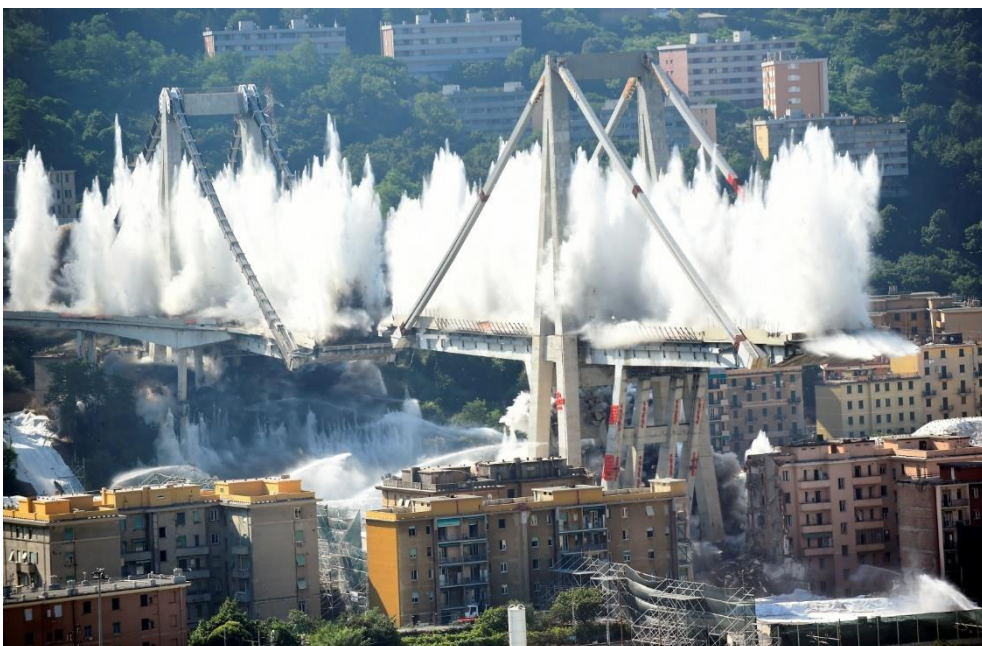
Slika 8. Rušenje ostatka Morandijevog mosta
