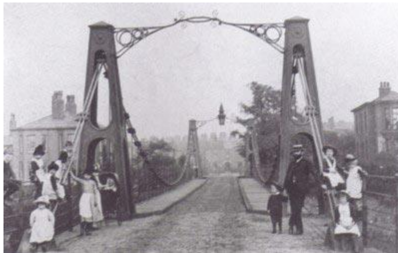
Slika 11. Obnovljeni most nakon urušavanja
