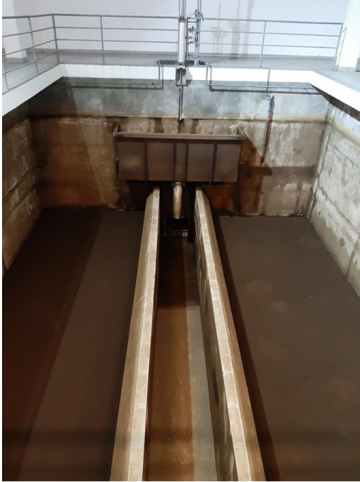
Slika 16.: Brzi filter, PKV Butoniga (Foto: Tamara Mošnja, 2021.)
