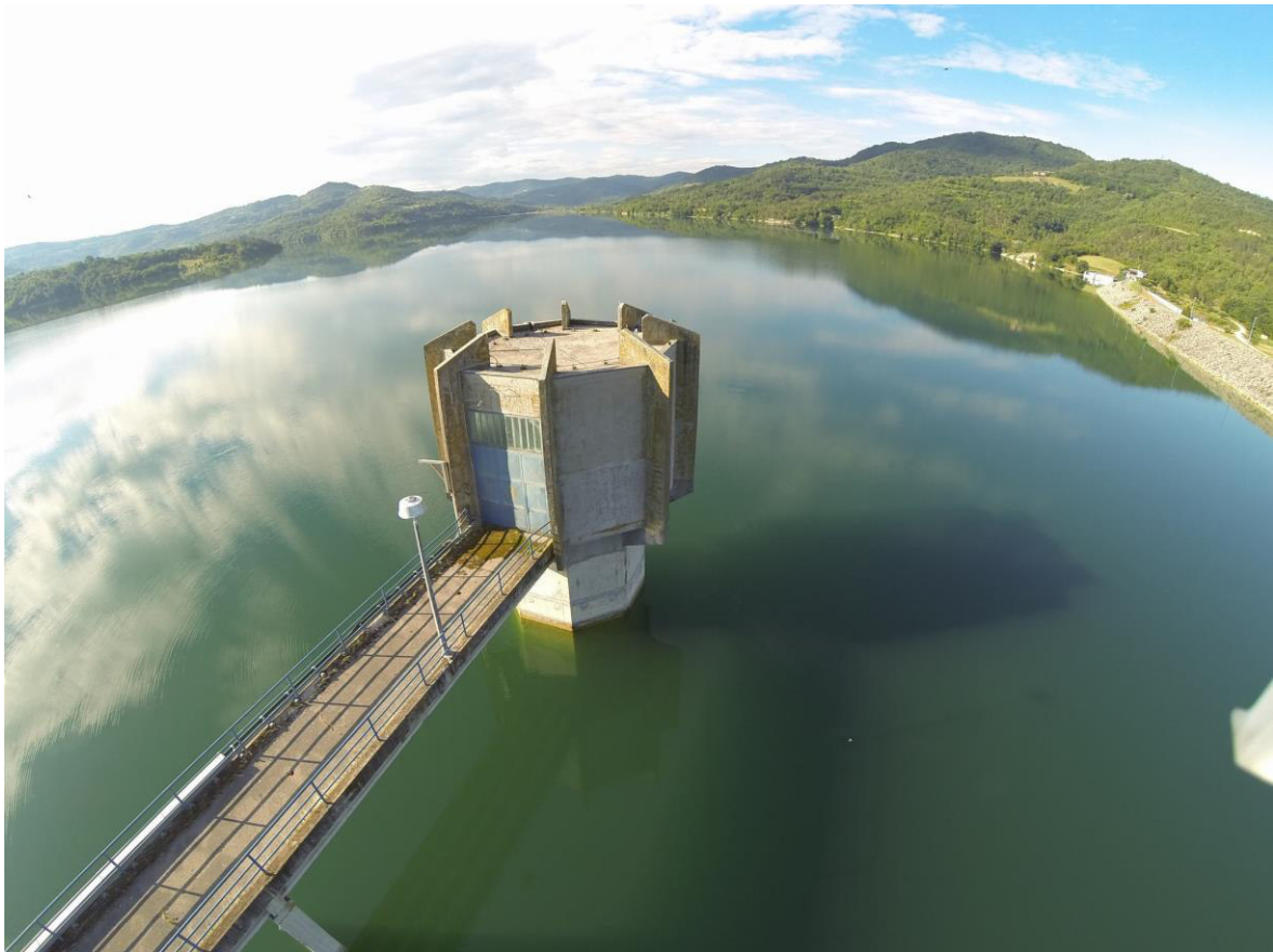
Slika 10.: Usisni toranj, akumulacija Butoniga [12]
