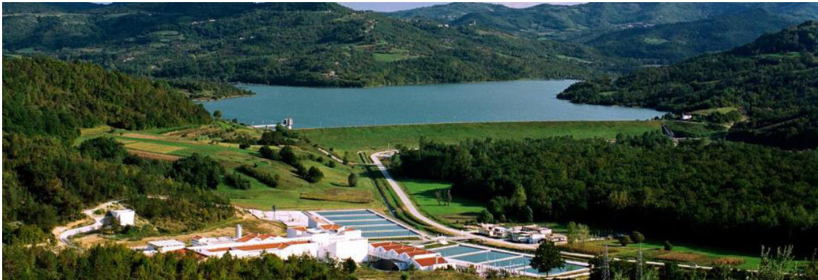
Slika 6.: Akumulacijsko jezero i postrojenje za kondicioniranje vode Butoniga [6]
