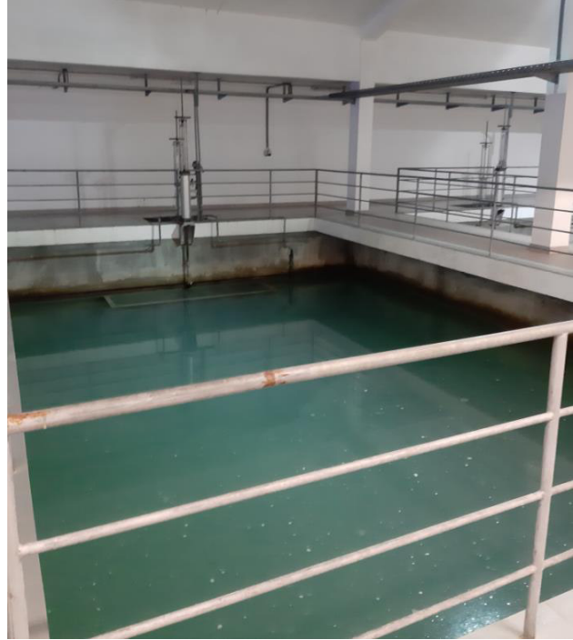
Slika 17.: Brzi filter, PKV Butoniga (Foto: Tamara Mošnja, 2021.)
