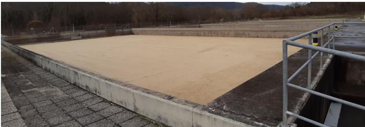
Slika 22.: Spori filter, PKV Butoniga (Foto: Tamara Mošnja, 2021.)
