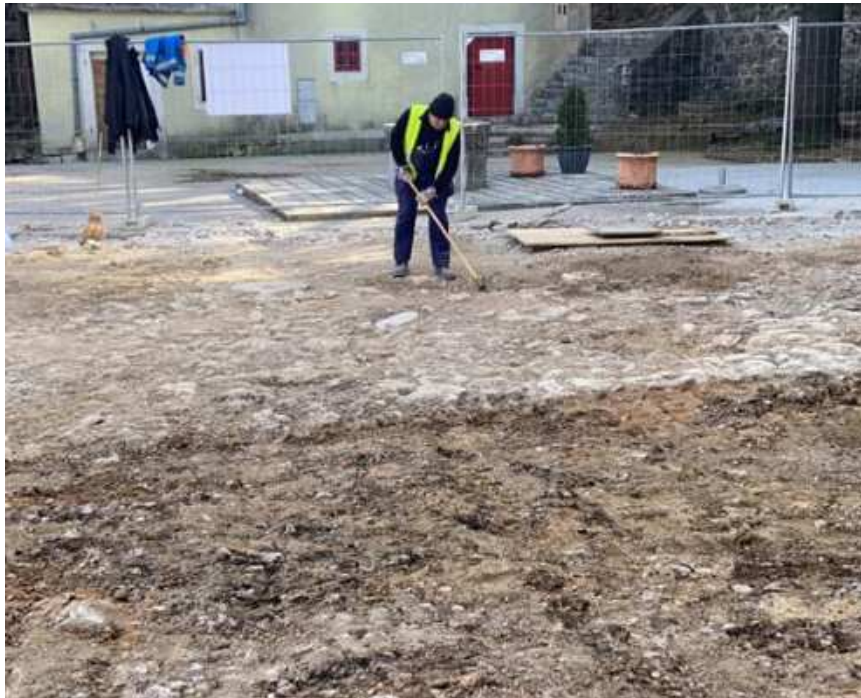
Slika 21: Ručno čišćenje pokrova cisterne (fotografirao autor, 2021)
