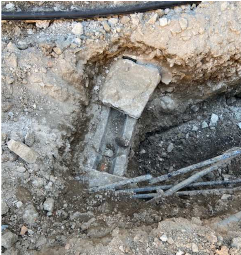
Slika 20: Kameni kanal i ostale ne označene instalacije (fotografirao autor, 2021)
