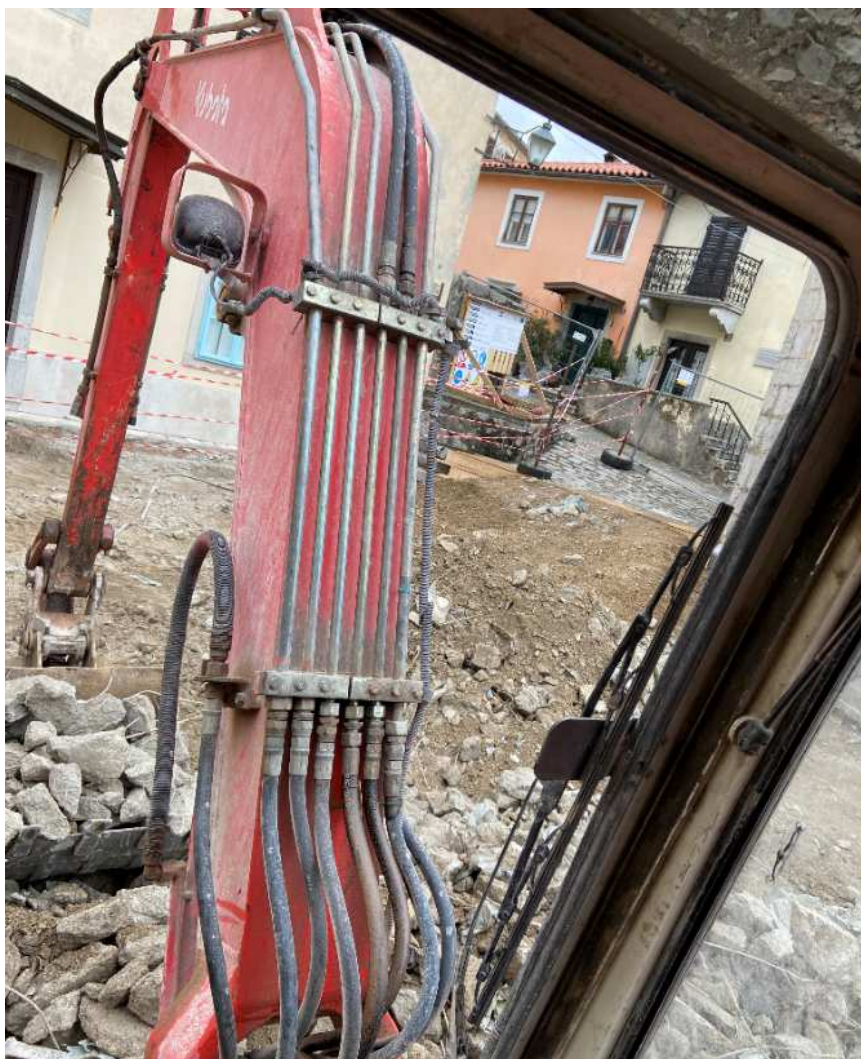
Slika 18: Odstranjivanje armirano betonske ploče iz perspektive strojara (fotografirao autor, 2021)
