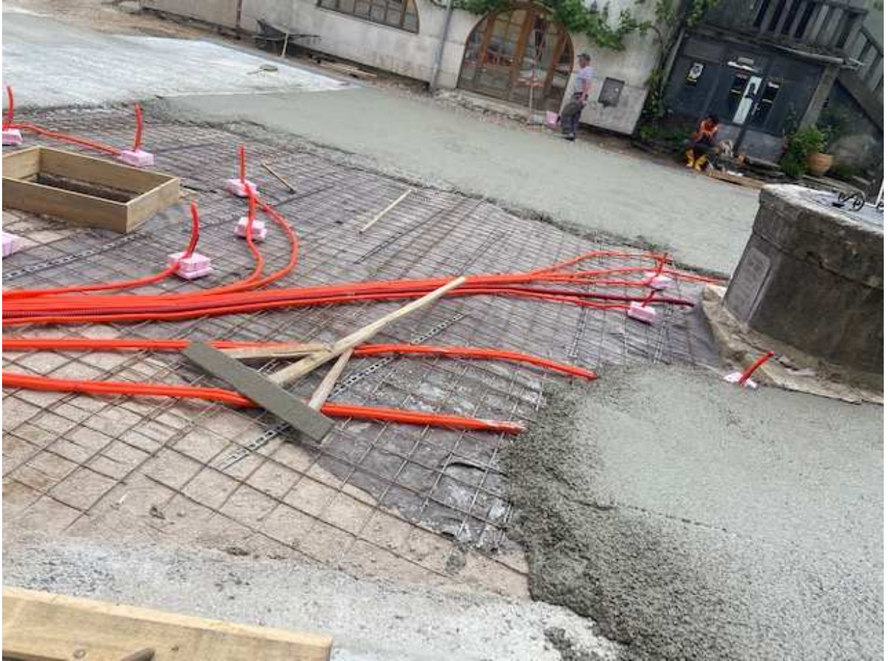
Slika 24: Betoniranje trga (fotografirao autor, 2021)
