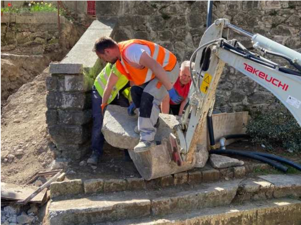
Slika 3: Poteškoće pri ugradnji stuba zbog težine/nedostatka opreme (fotografirao autor, 2021)
