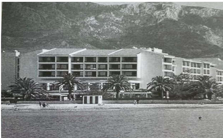
Slika 85: Hotel Topolica, Bar, Pročelja (Izvor: Nikšić Olujić, 2015:105)
