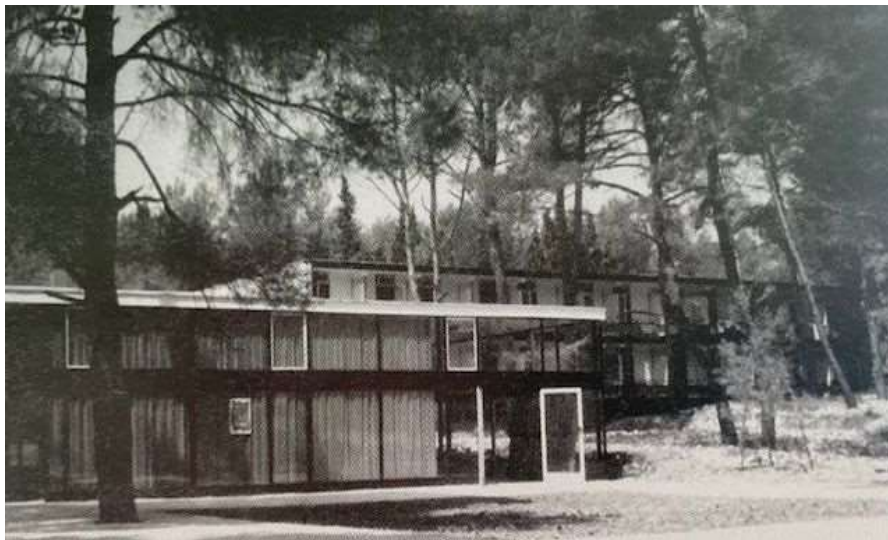
Slika 61: Hotel Helios, Mali Lošinj, Prednje pročelje (Izvor: Nikšić Olujić, 2015:58)
