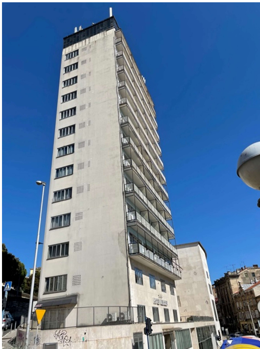
Slika 49: Slika jugozapadnog pročelja današnjeg hotela Neboder, (Foto: autor, 2021)
