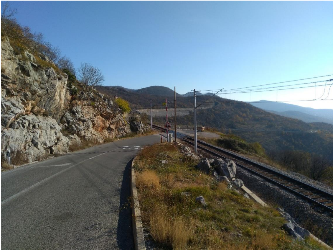
Slika 4: Željezničko cestovni prijelaz Milja (fotografija autora)
