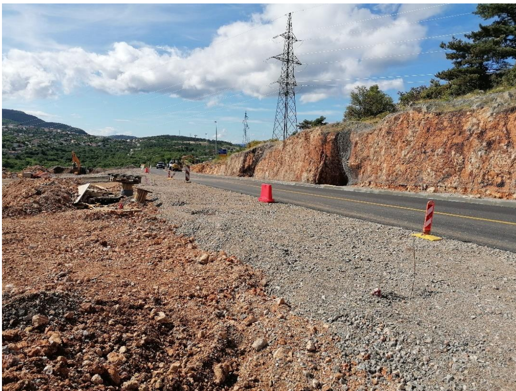
Slika 16: Stanje radova na raskrižju na dan 04.07.2021. (fotografija autora)
