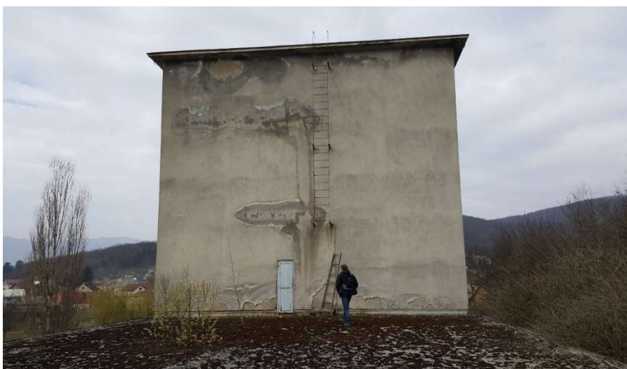
Slika 43: Pogled s ravnog krova na zapadni toranj
