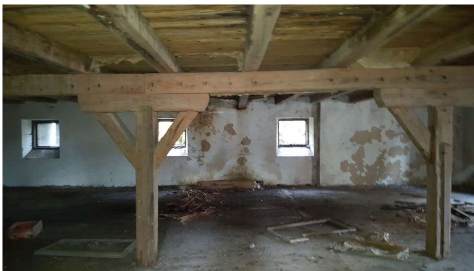
Slika 46: Drveni grednik starije gradnje
