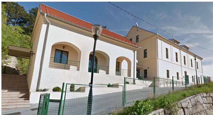
Slika 36: Zgrada Đačkog doma – nekada bolnice i mrtvačnice
