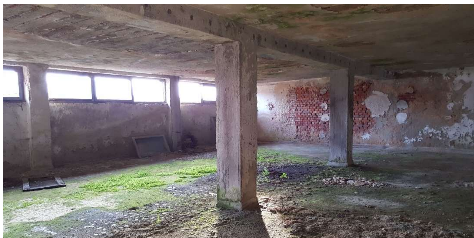
Slika 47: Armiranobetonske grede i stupovi nadgradnje
