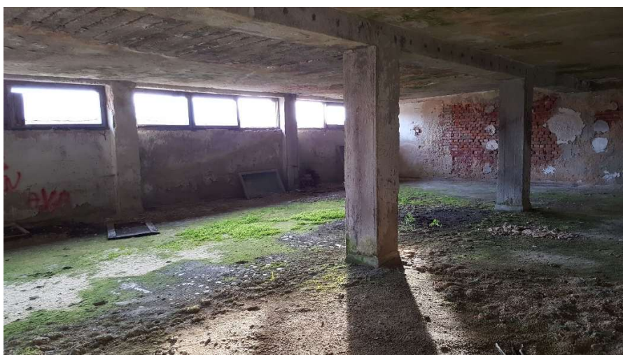
Slika 40: Konstrukcije betonske nadgradnje iznad kamenog prizemlja, interijer prostora klijališta
