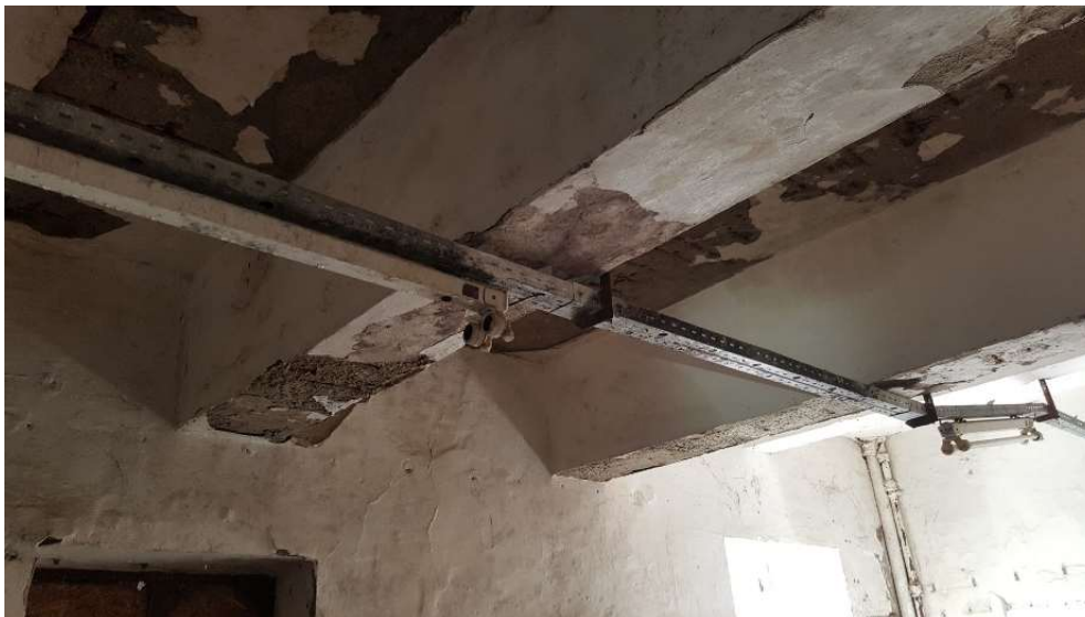
Slike 37: Konstrukcije betonske nadgradnje iznad kamenog prizemlja
