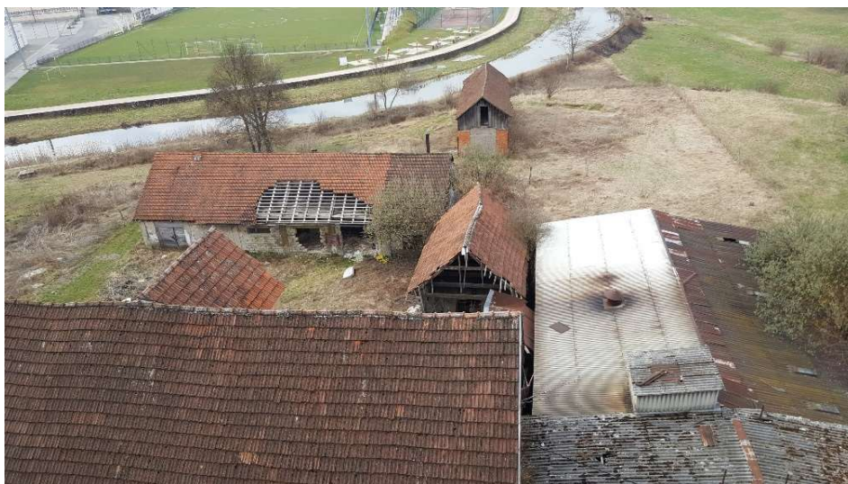
Slika 41: Pogled s ravnog krova na građevine bivšeg pogona likera, uklonjene 2019. god.
