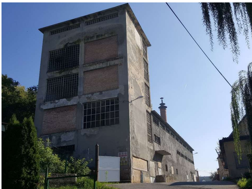
Slika 42: Pogled na zapadni toranj i moderniji betonski dio zgrade pivovare
