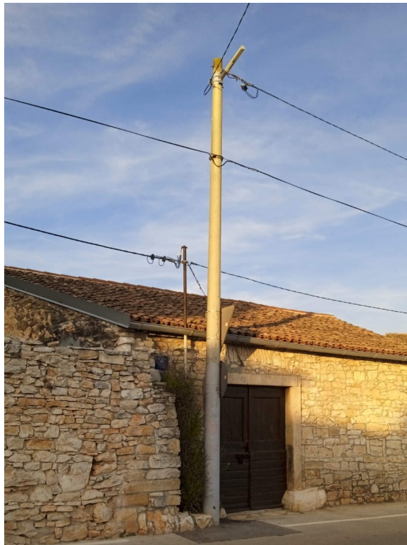
Slika 8: Betonski stup (Izradio Autor)
