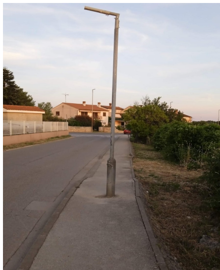
Slika 2: Loše pozicioniran stup rasvjete (Izradio Autor)
