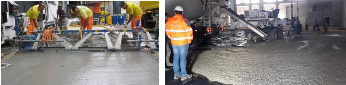
Slika 3: Izrada betonske ploče lijevanjem samozbijajućeg betona [14]
