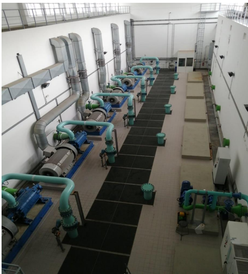
Slika 38- Pumpanje u tlačni vod [12]
