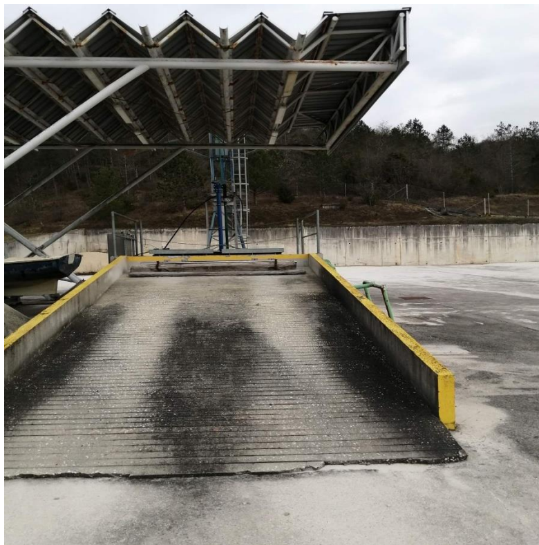
Slika 39- Stanica za čišćenje pijeska od sporih filtra [12]
