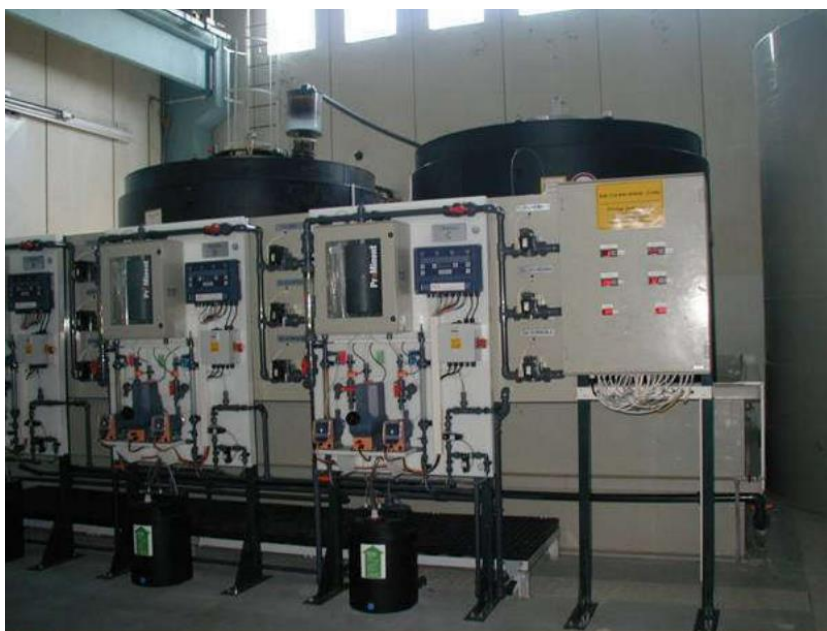
Slika 24 - Uređaj za dezinfekciju klordioksidom [2]
