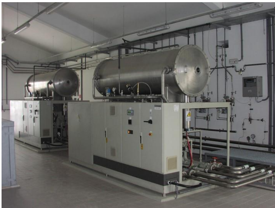
Slika 35 - Komora za ozoniranje [12]
