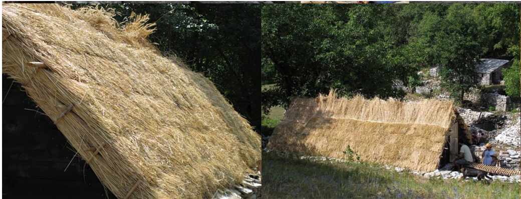
Slika 67: Petrebišća – obnovljeni slamnati krov
