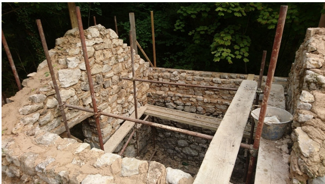
Slika 56: Mlin nakon zidanja do visine izvornih gabarita
