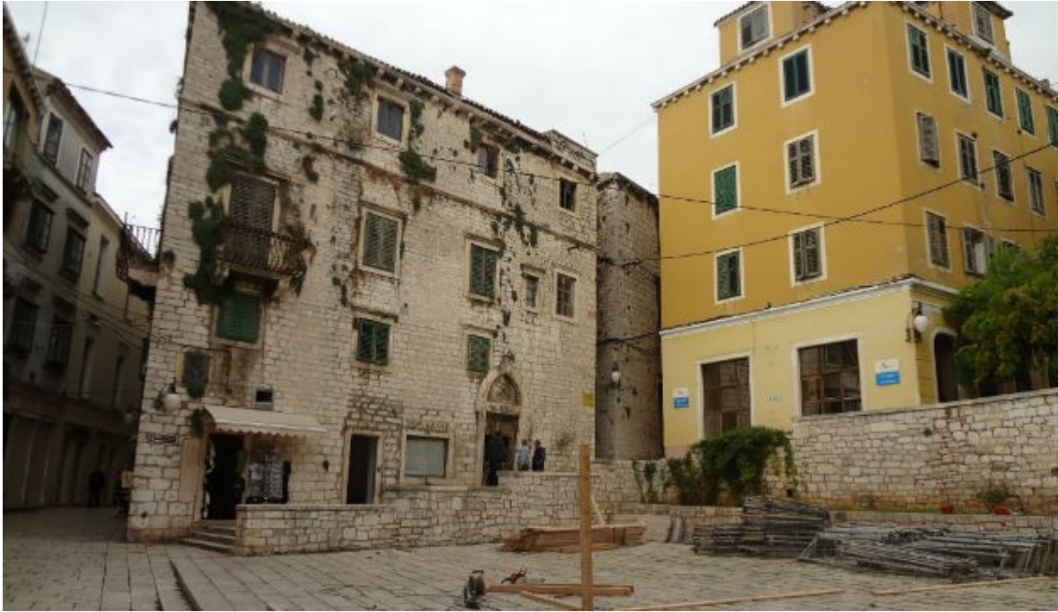
Slika 29: Palača Marenci prije obnove
