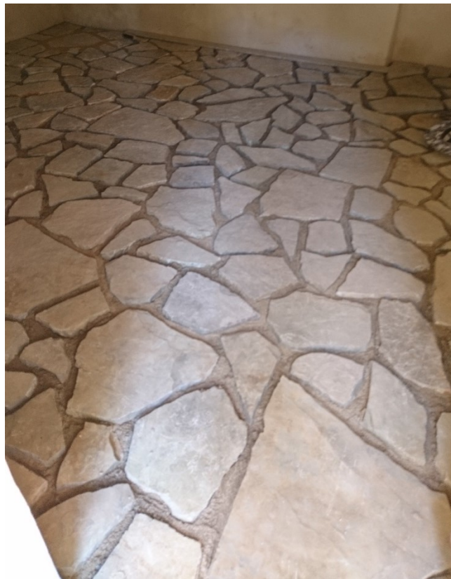
Slika 46: Kameno opločenje prizemlja prije fugiranja
