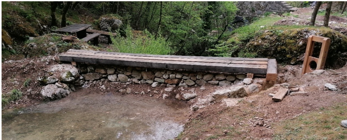
Slika 61: Izvedba brane, mostića i zapornice
