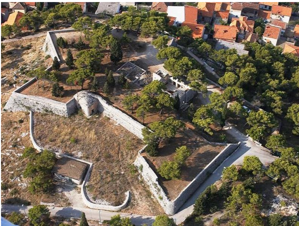
Slika 15: Tvrđava Barone prije obnove
