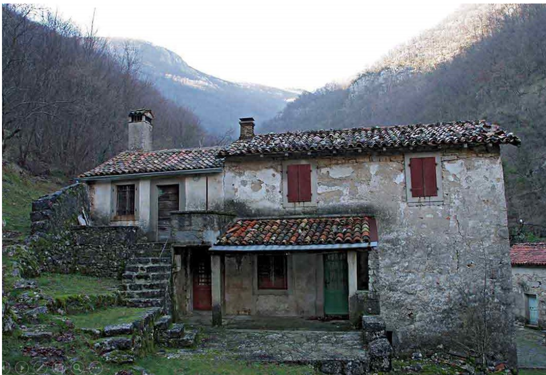
Slika 42: Stambeni objekt u Trebiščima prije revitalizacije
