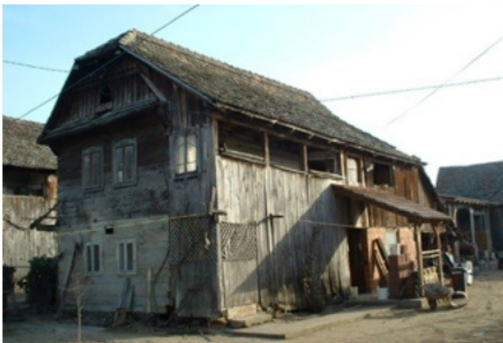
Slika 27: Stambena katnica Čigoč br. 57 prije obnove
