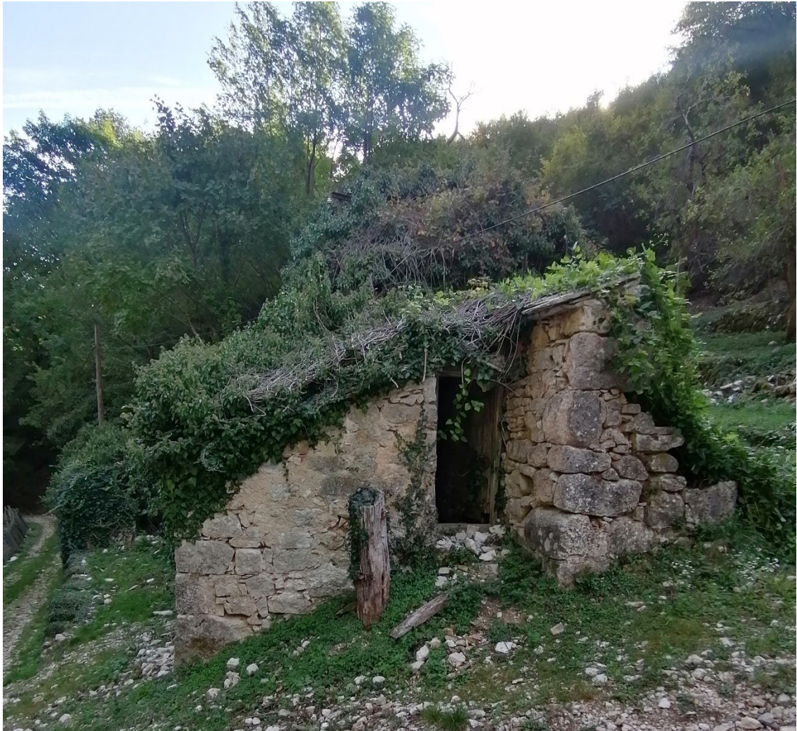
Slika 39: Ruševine nekadašnjeg gospodarskog objekta s jednostrešnim krovom i pokrovom od kamenih ploča
