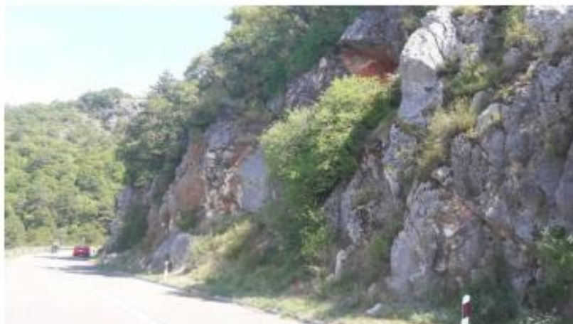
Slika 116. Predmetna kosina u sklopu inženjerskog bloka 2
