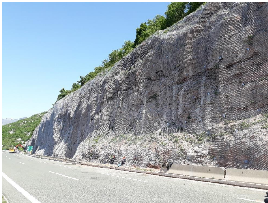
Slika 61. Primjer korištenja 3STUTOR mreže za zaštitu pokosa
