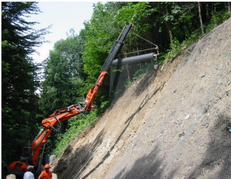
Slika 58. Prikaz izvedbe TECCO mreže na pokosu
