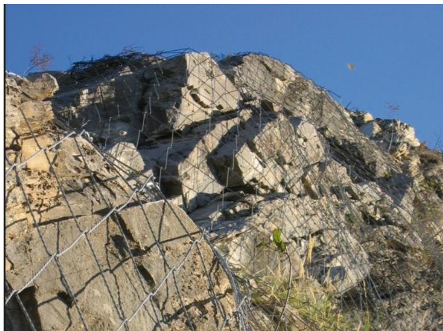
Slika 60. Primjer izvedenog SPIDER sustava mreža
