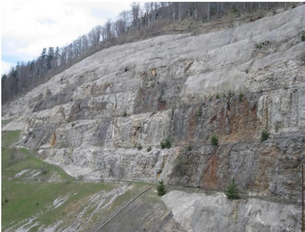
Slika 110. Pogled na pokos predusjeka Tunela Vrata
