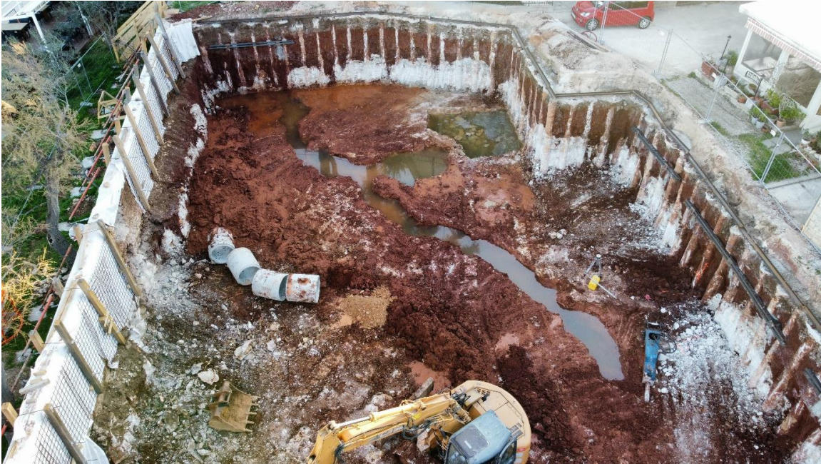
Slika 16: Pojava podzemne vode pri iskopu građevne jame [23]
