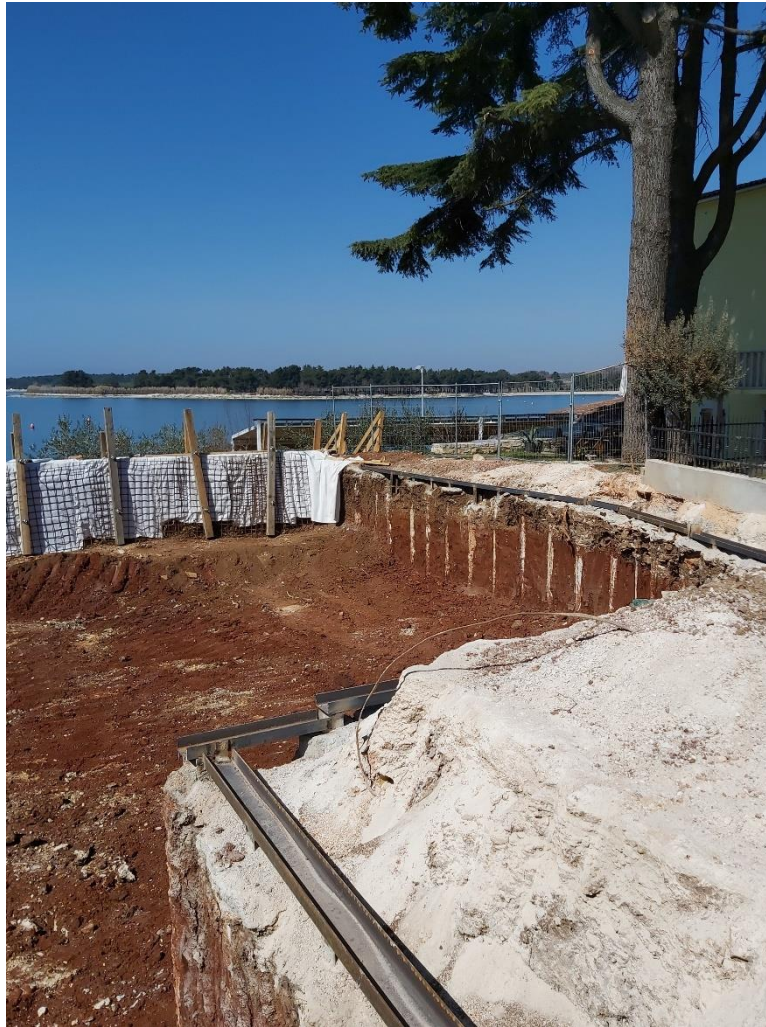
Slika 21: UPN profili postavljeni na mikropilote (zona II)
