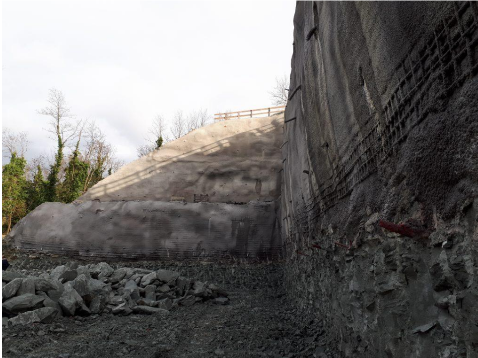
Slika 1: Osiguranje građevne jame mlaznim betonom i štapnim sidrima [9]
