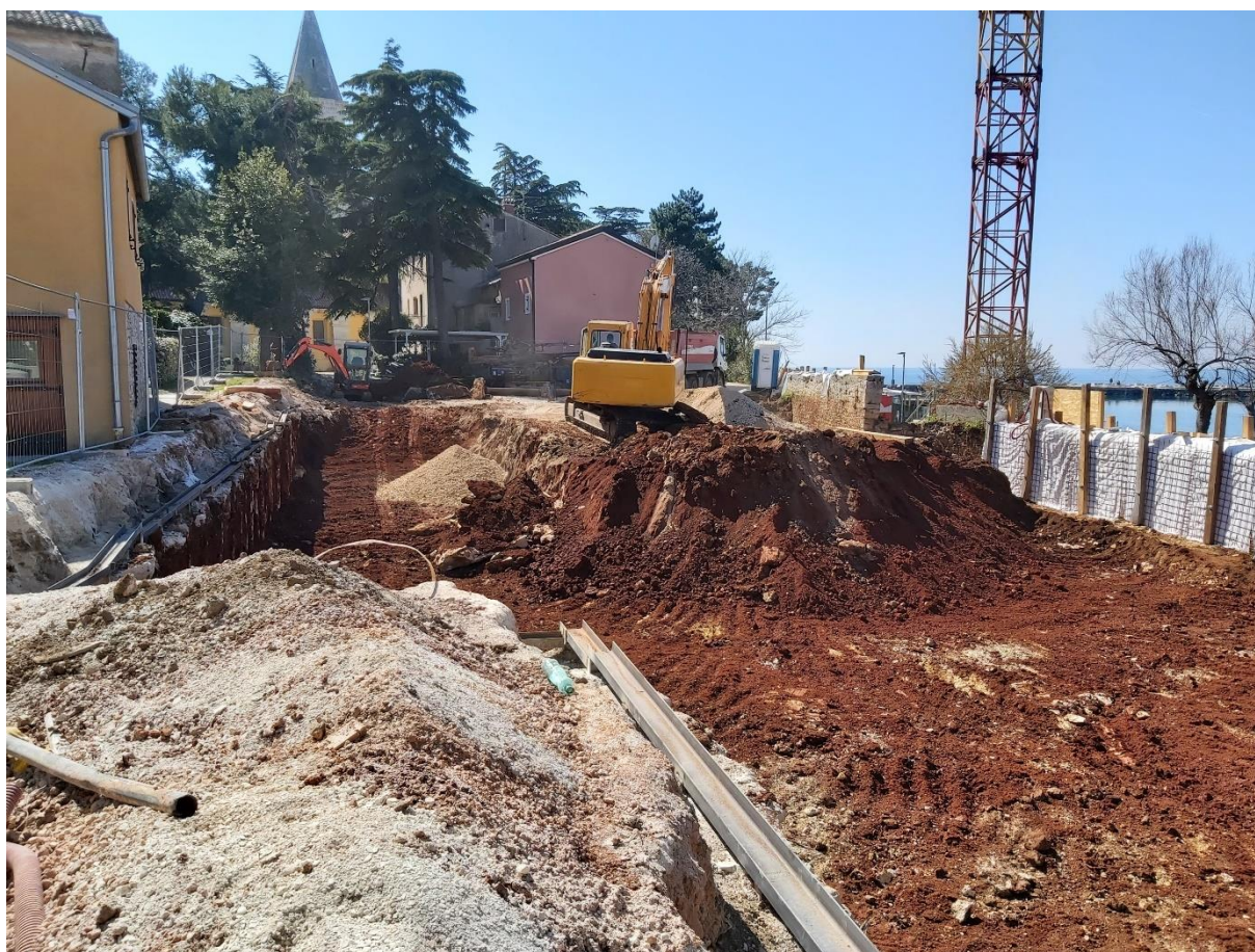
Slika 18: Iskopana crvenica na lokalitetu
