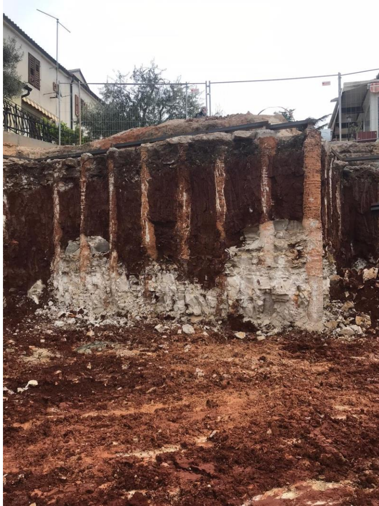
Slika 15: Pružanje slojeva tla i pilotska stijena (Zona II)
