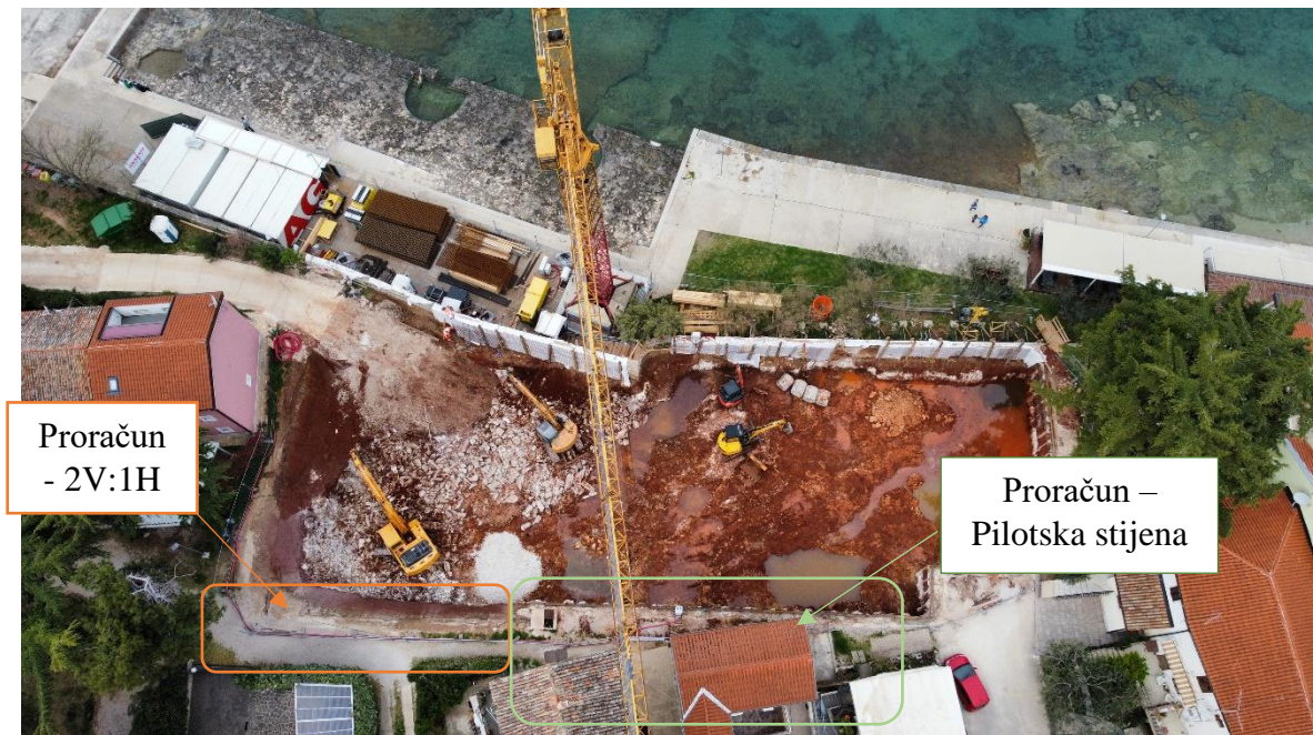
Slika 24: Zone obuhvata proračuna pilotske stijene i iskopa u nagibu 2V:1H [23]
