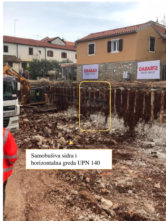
Slika 22: Samobušiva sidra u pilotskoj stijeni (zona II)
