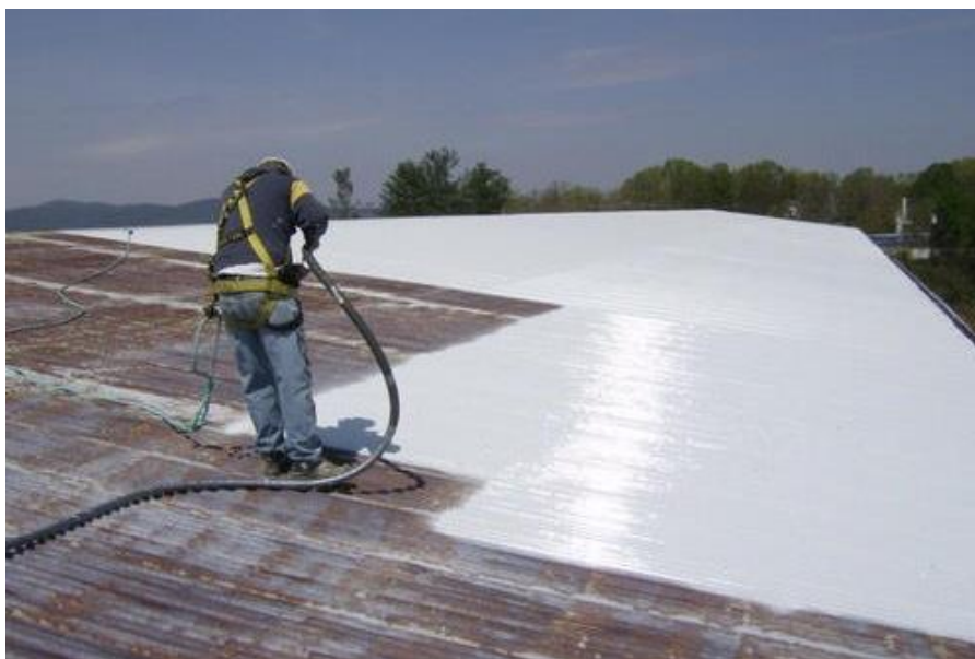
Slika 49: Nanošenje termoizolacijskog sloja špricanjem
