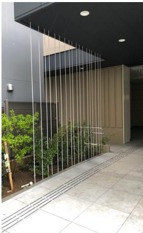
Slika 15: Prikaz korištenja šipki u svrhu očvršćivanja, a da se pritom ne narušava estetski dojam [8]
