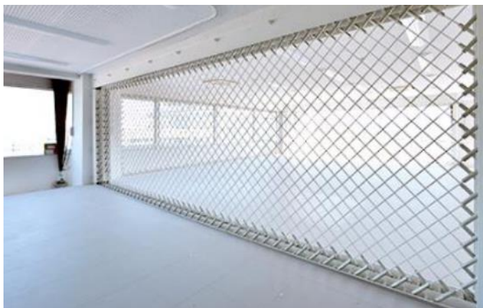
Slika 13: Primjena šipki za unutrašnji posmični zid [7]
