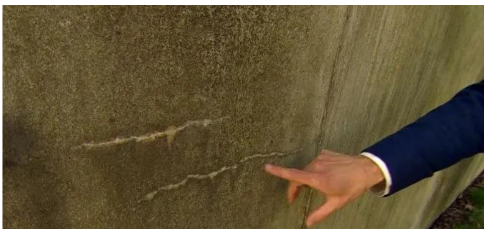
Slika 37: Primjer primjene samozacjeljujućeg betona [ https://www.greenoptimistic.com/bio-concrete-heals-cracks/ ]
