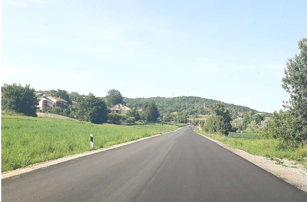
Slika 11: Novoobnovljeni dio ceste Pazinski Novaki-Cerovlje [foto autor]
