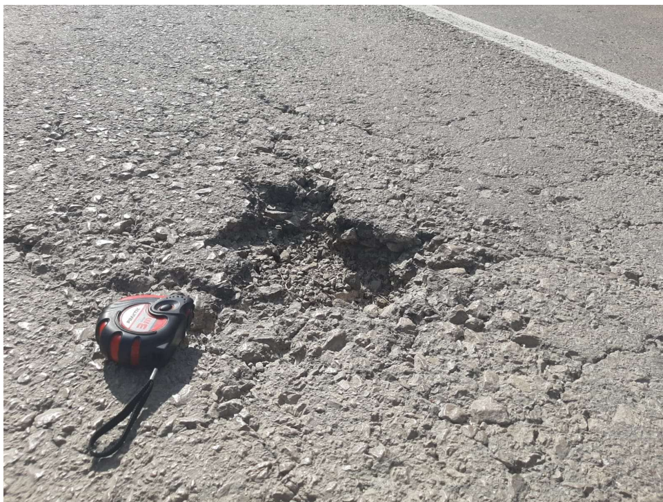
Slika 25: Udarne jama niskog stupnja oštećenja [foto autor]
