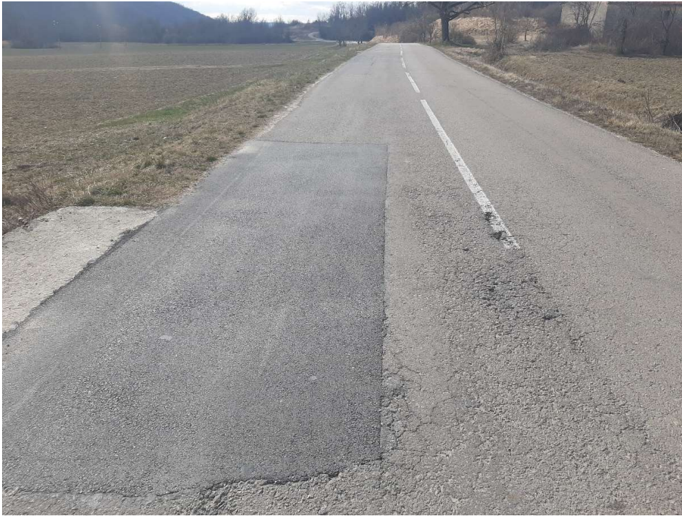
Slika 30: Popravci niskog stupnja oštećenja [foto autor]
