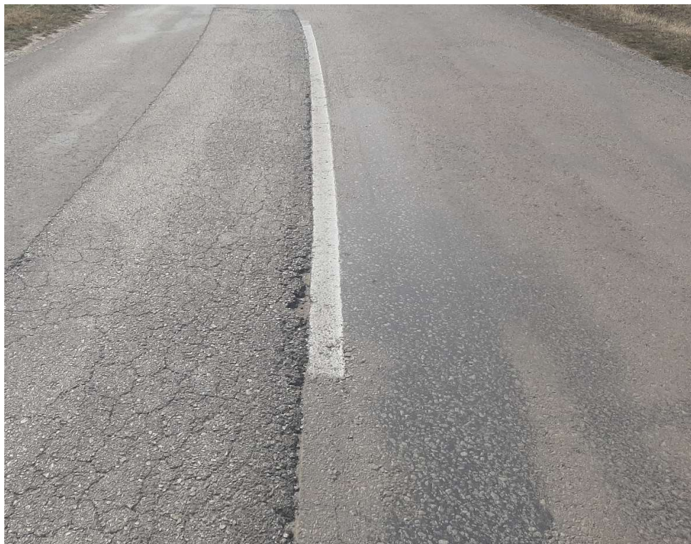
Slika 34: Iznožavanje veziva niskog stupnja oštećenja [foto autor]
