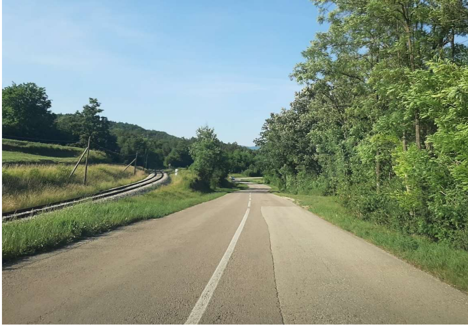
Slika 9: Horizontalna signalizacija na cesti Cerovlje-Borut [foto autor]
