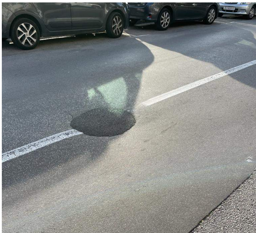
Slika 90: Popravak (umjeren stupanj oštećenja)
