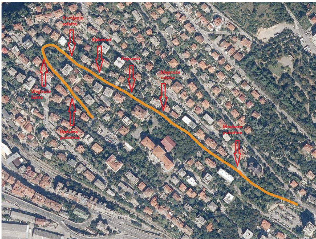
Slika 55: Šetalište Ivana Gorana Kovačića i pozicije oštećenja
