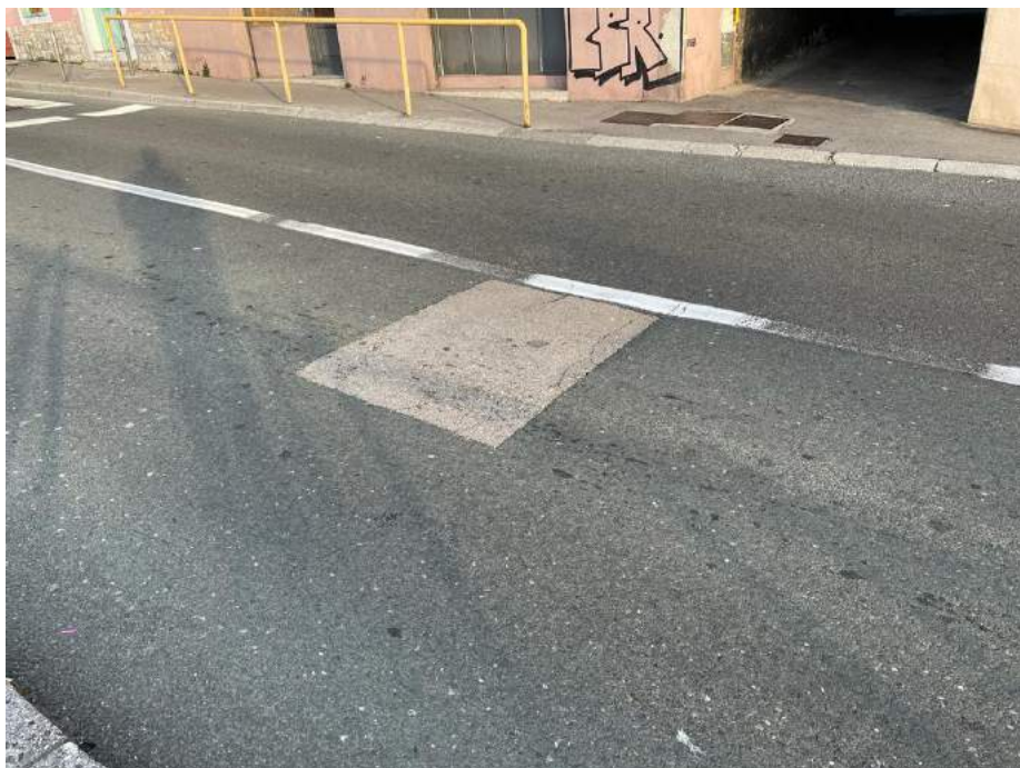
Slika 51: Popravak (nizak stupanj oštećenja)
