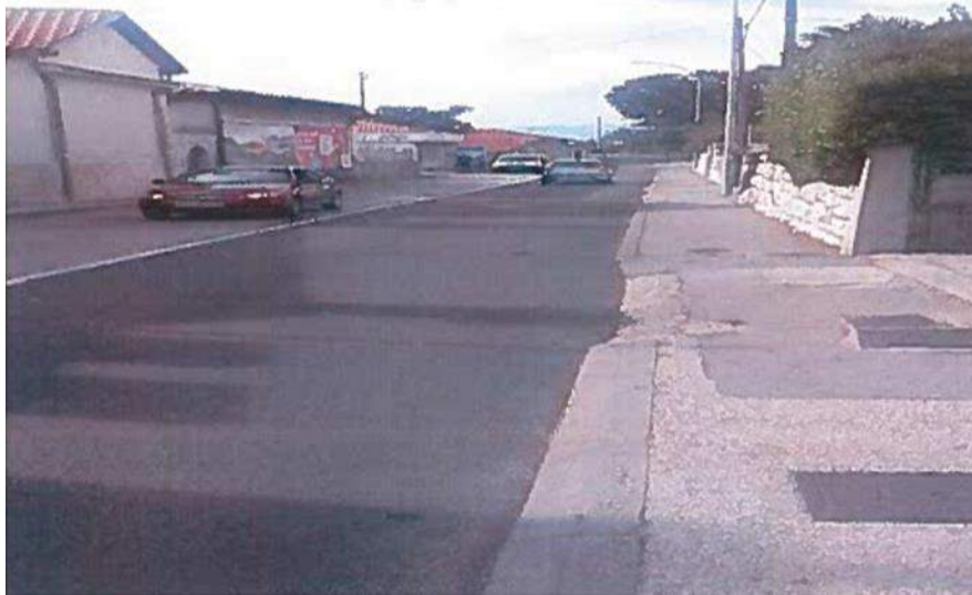
Slika 39: Rekonstrukcija ulice Tome Strižića [14]
