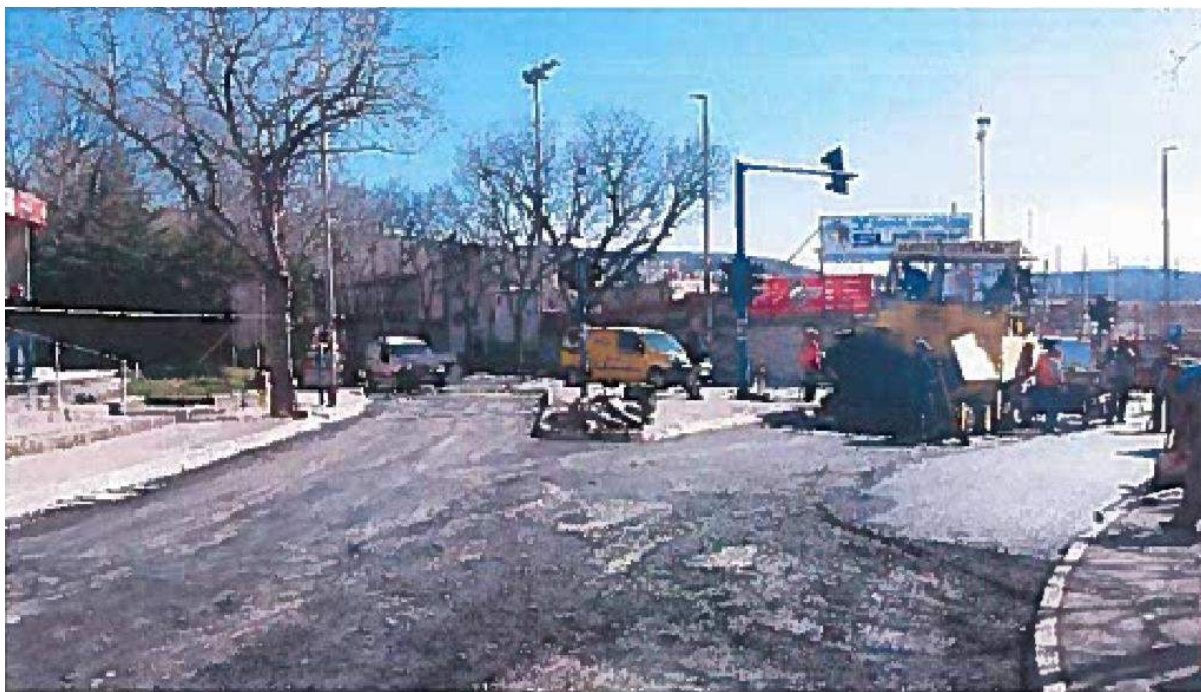
Slika 98: Sanacija kolnika u Mihanovićevoj ulici [14]
