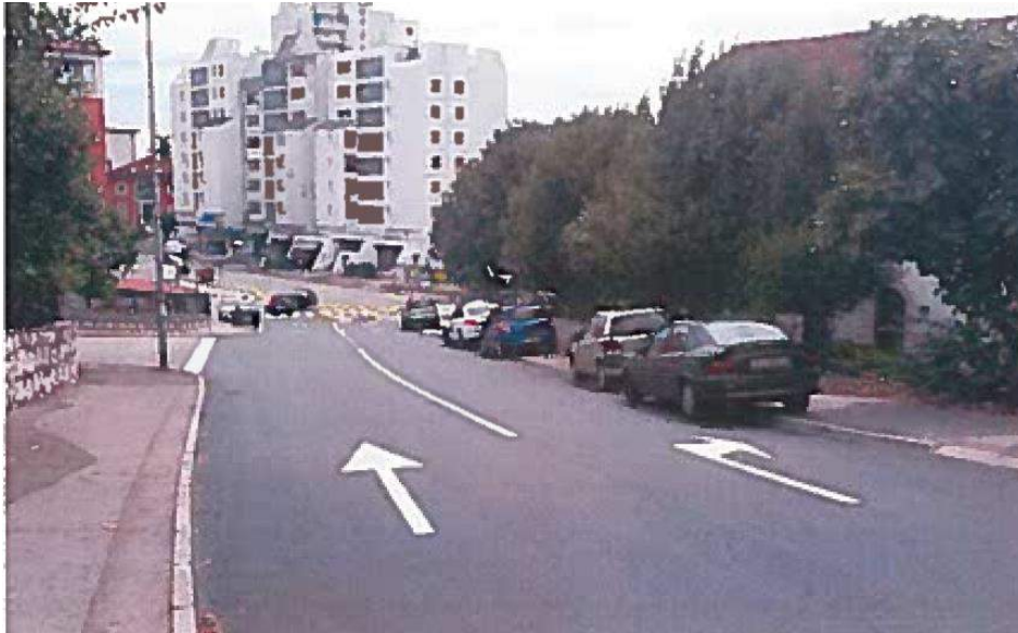
Slika 77: Rekonstrukcija ulice Martina Kontuša [14]
