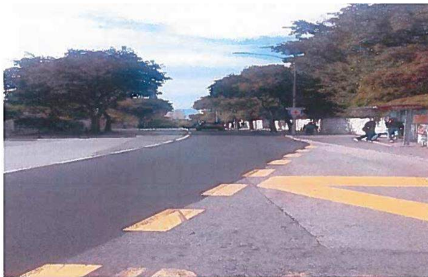
Slika 40: Rekonstrukcija ulice Tome Strižića [14]
