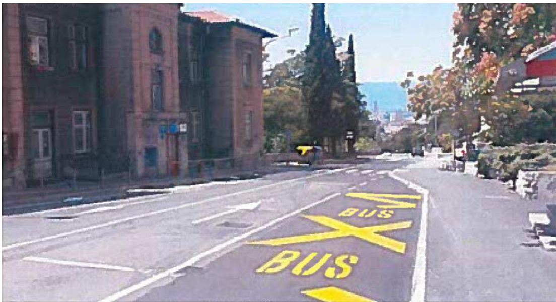
Slika 32: Sanacija kolnika i nogostupa u Kumičićevoj ulici [14]
