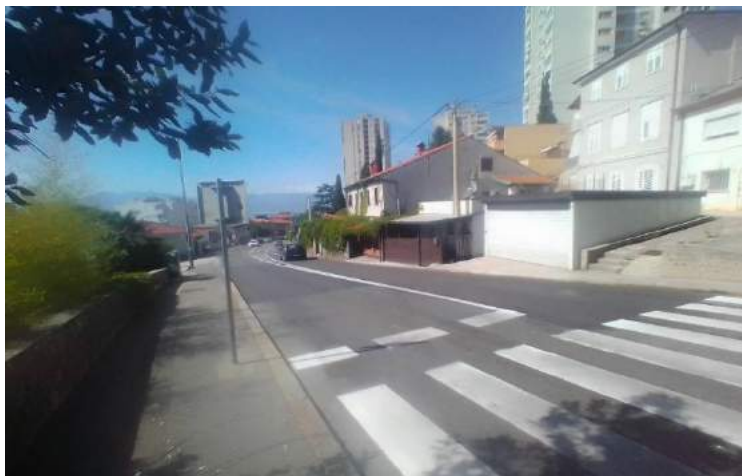
Slika 30: Rekonstrukcija Kumičićeve ulice [13]
