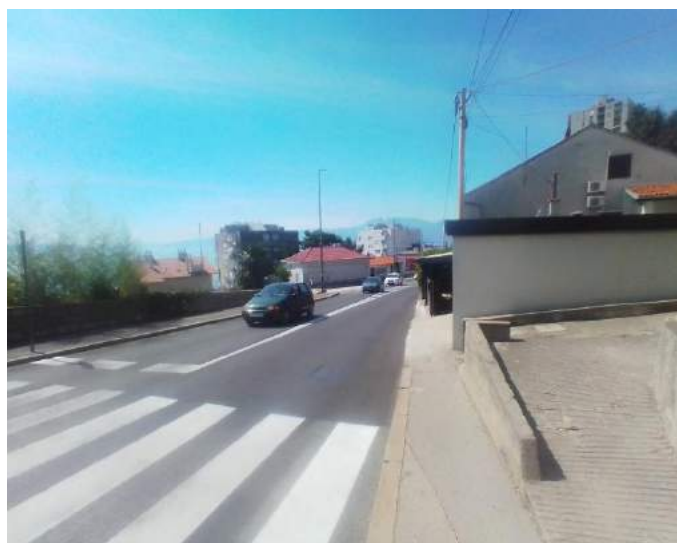
Slika 31: rekonstrukcija Kumičićeve ulice [13]
