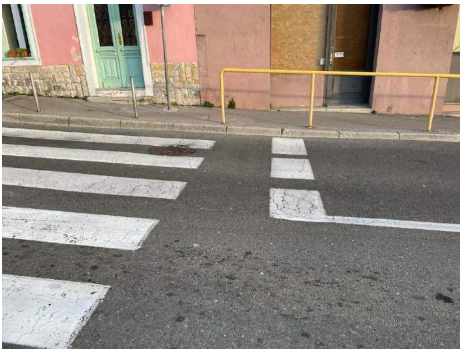
Slika 52: Mrežaste pukotine (umjeren stupanj oštećenja)
