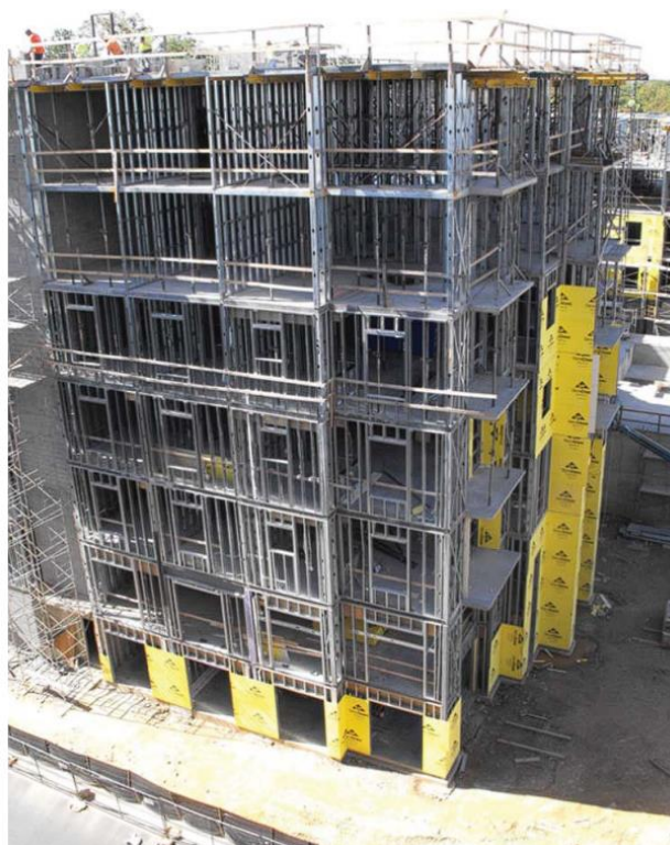
Slika 14: Višekatna zgrada od tankostijenih hladno oblikovanih čeličnih profila [5]
