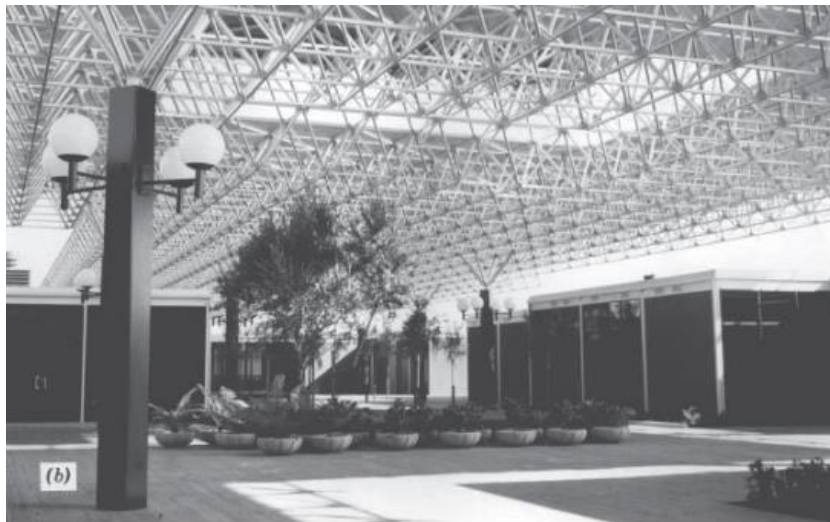
Slika 22: Prostorna rešetka od tankostijenih čeličnih profila [5]
