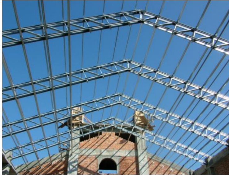
Slika 21: Krovna rešetkasta konstrukcija [2]
