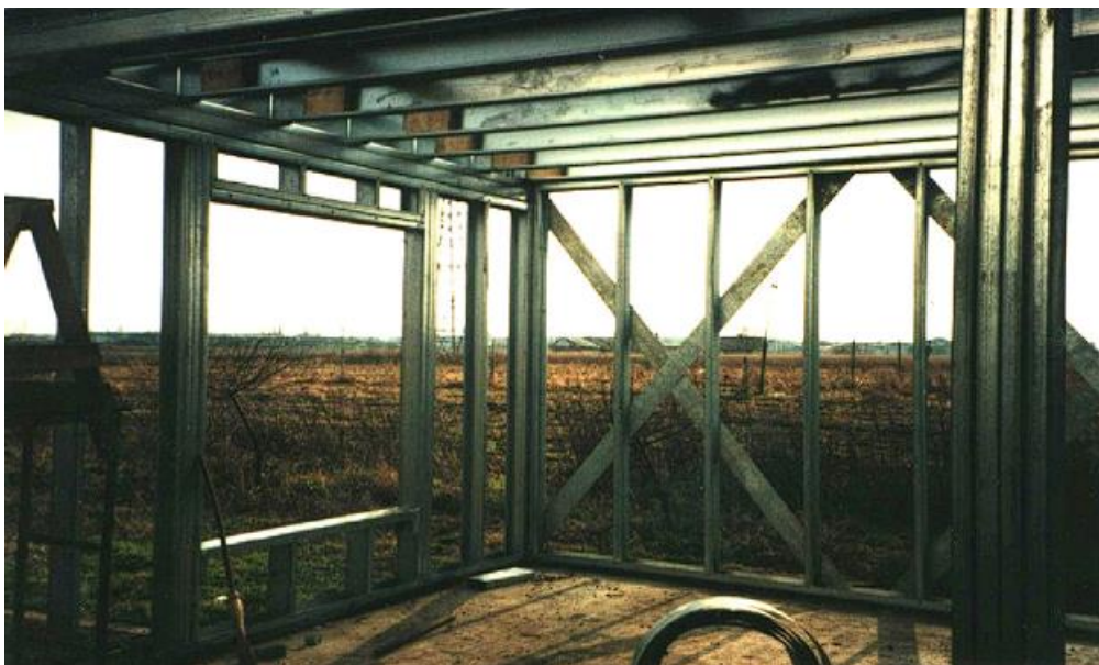
Slika 15: Nosivi zid od tankostijeni hladno oblikovanih čeličnih profila [2]
