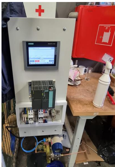
Slika 22. Mjerenje tlaka vode u prostoru studentskog paviljona br. 4, Ulica Radmileatejčić 5, Rijeka.
