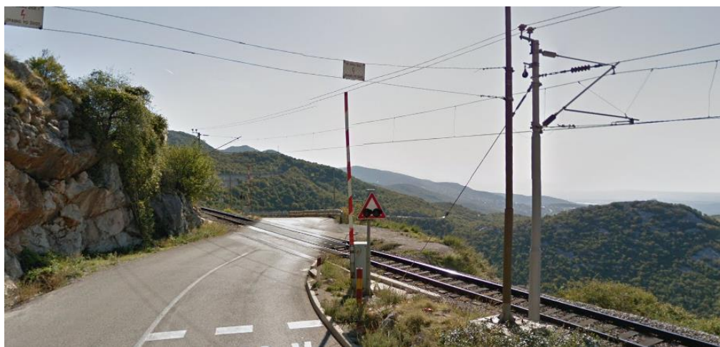
Slika 17: Željezničko cestovni prijelaz „Meja-Milja“ iz smjera sjever
