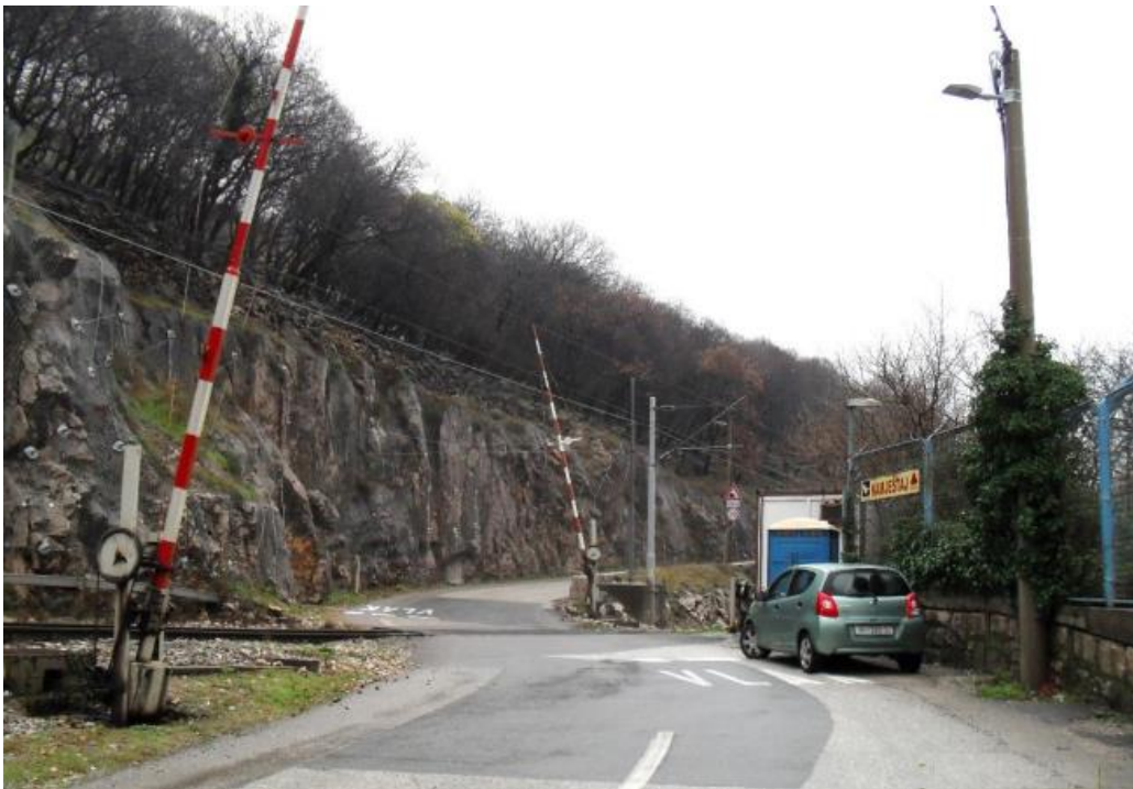
Slika 25: Željezničko-cestovni prijelaz „Bakar 1“ preuzeto iz [8]
