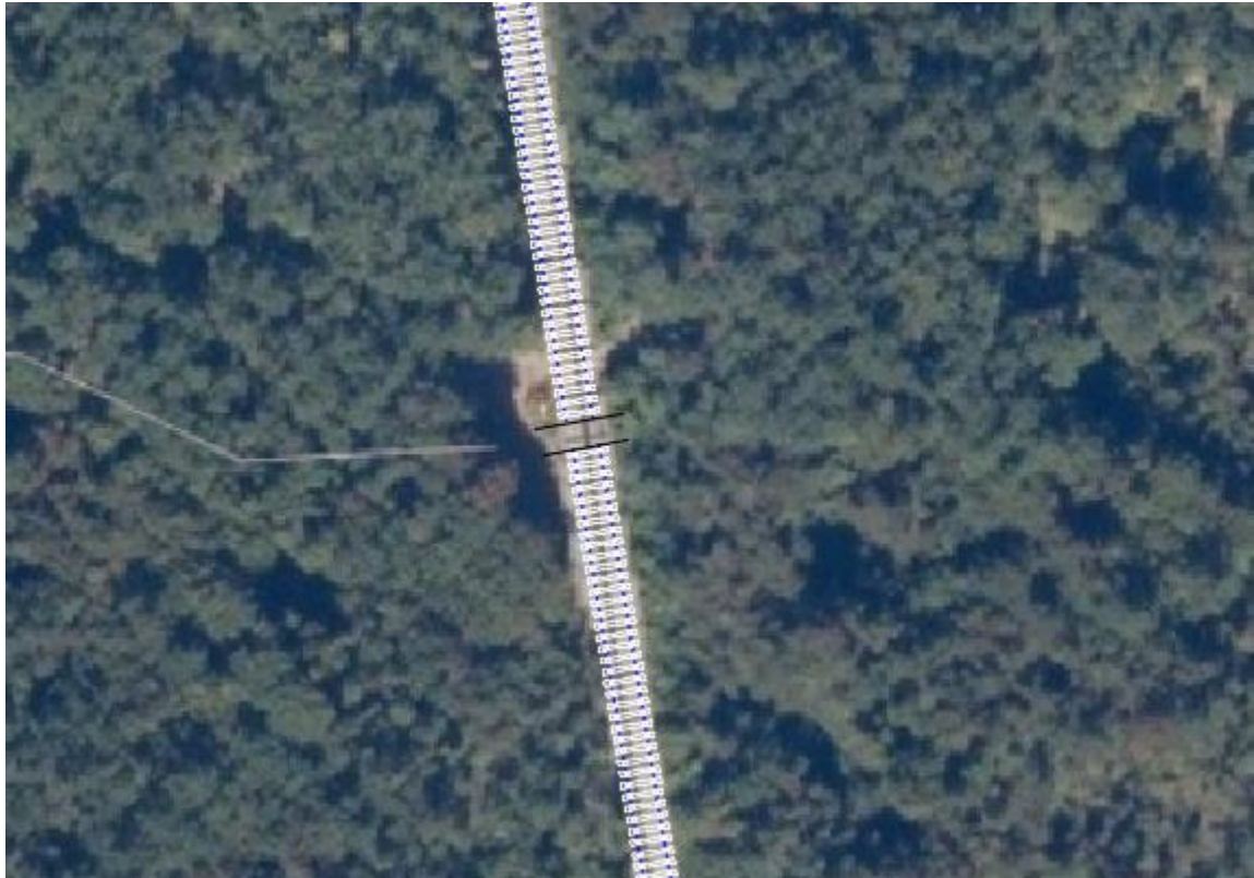
Slika34: Postojeće stanje željezničko-cestovnog prijelaza „Brgud“
