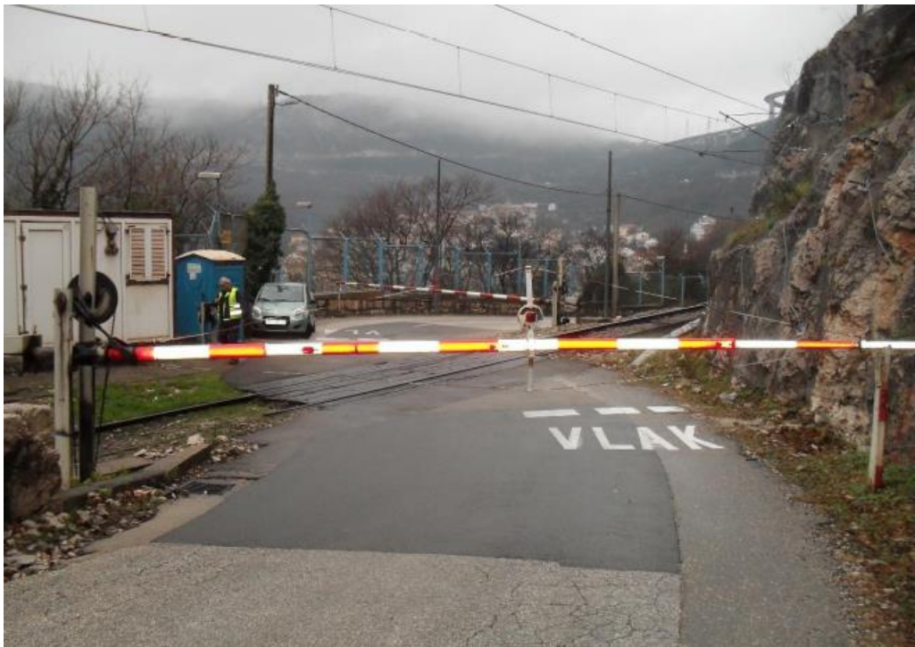
Slika 11: Uređaji sa ručnim postavljanjem – puni branici [7]
