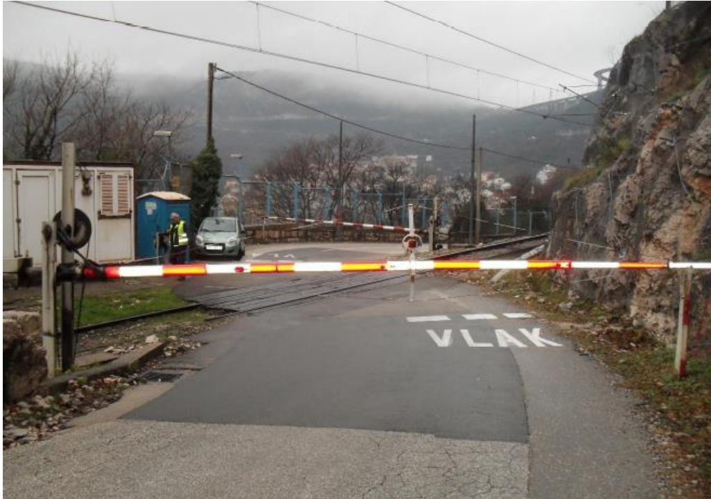
Slika 26: Željezničko-cestovni prijelaz „Bakar 1“ preuzeto iz [8]
