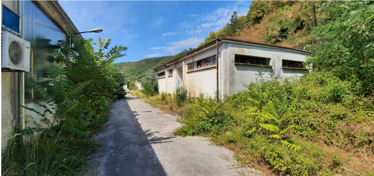
Slika 49.: Zgrada svlačionica i kupaona danas
