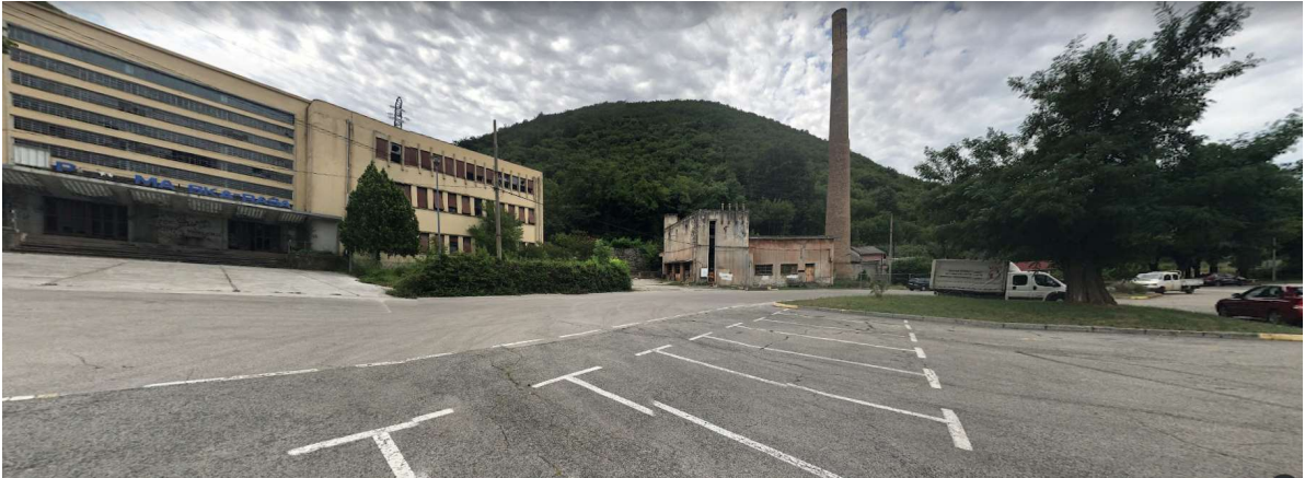
Slika 60.: Parkiralište ispred upravne zgrade
