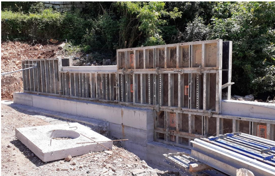
Slika 14. Prikaz izrade potpornog zida Z2.
