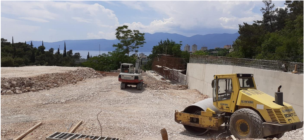
Slika 13. Prikaz izrade nasipa
