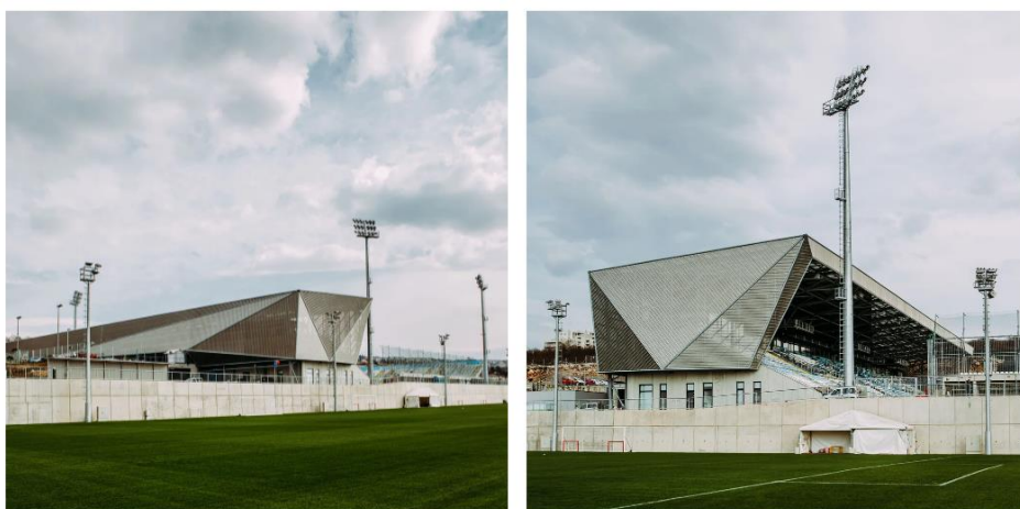
Slika 1. Zapadna tribina Stadiona Rujevica [2]
