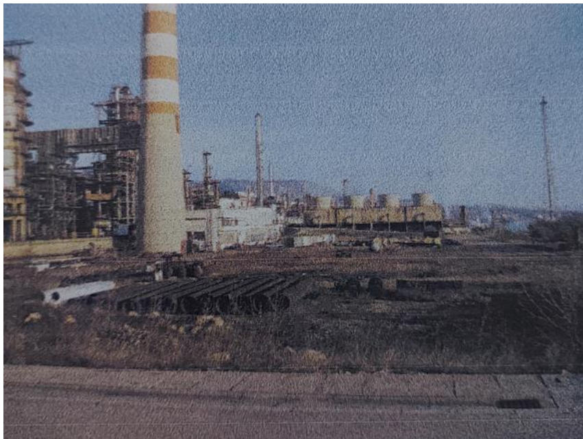
Slika 11: Površina za izgradnju Hidrokreking kompleksa (Izvor: Studija o utjecaju na okoliš za postrojenje Hidrokreking kompleksa i pomoćnih jedinica u INA d.d. – Rafinerija nafte Rijeka, 2006.)
