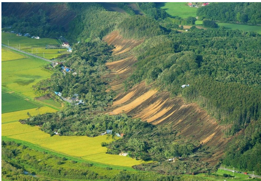
Slika 1.1: Klizište uzrokovano potresom, 8.rujan 2018.Hokaido, Japan [1]
