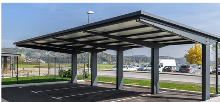
Slika 4 - Primjer konzolne nadstrešnice [3]
