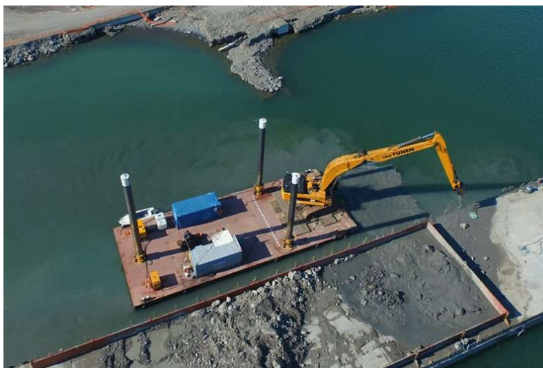
Slika 42 Izrada nasipane građevine s mora pomoću pontona (Izvor: https://mpsbv.com , 30.8.2022)
