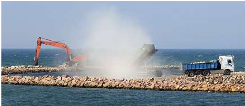
Slika 41 Izrada nasipanog lukobrana kopnenom mehanizacijom (Izvor: www.wikiwand.com/ , 30.8.2022)
