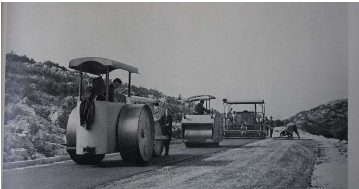
Slika 2: Prikaz asfaltiranje Jadranske magistrale [3]
