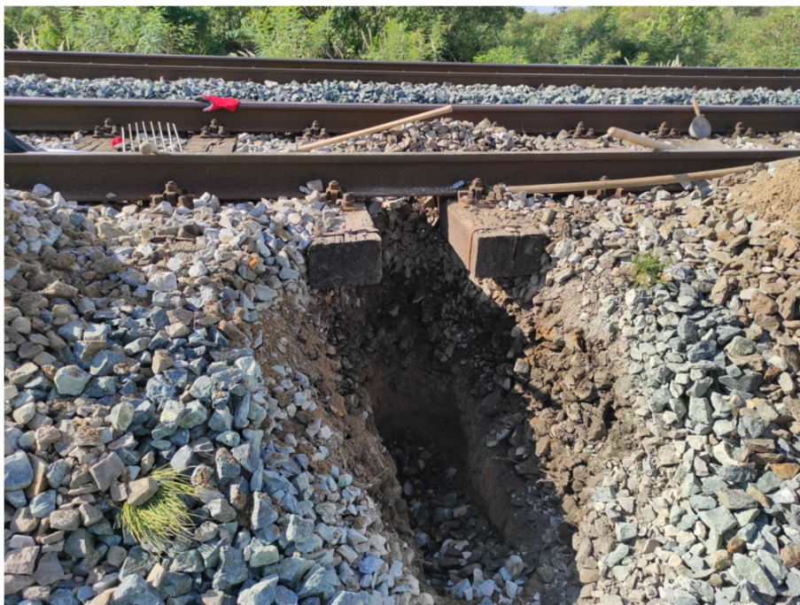
Slika 8. Sondažna jama SJ-15 na stacionaži 224+100 (Geotech d.o.o)
