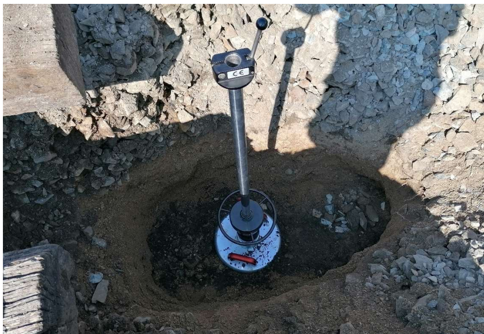
Slika 13. Ispitivanje sloja posteljice dinamičkom pločom u sklopu sondažne jame SJ-05 (Geotech d.o.o.)
