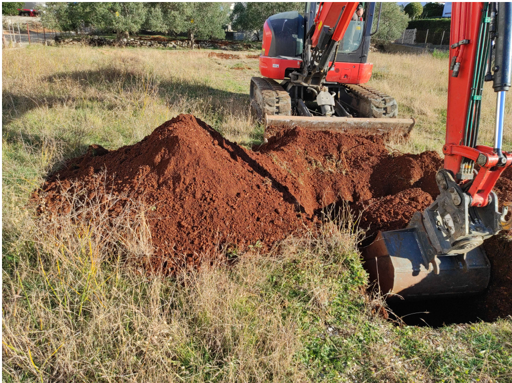
Slika 2. Strojni iskop sondažne jame
